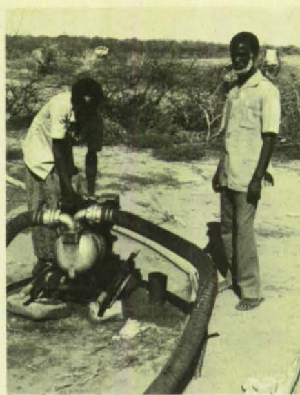
Mit Hilfe des MHD konnte in verschiedenen somalischen Flüchtlingslagern die Trinkwasserversorgung sichergestellt werden.
