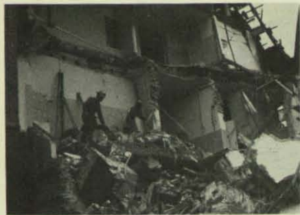
Ein idealer Übungsplatz: ein abbruchreifes Krankenhaus. (Foto: Wieczorek)
