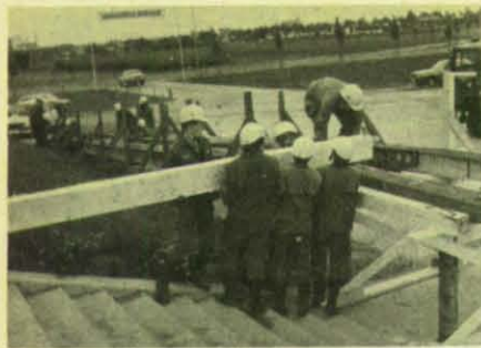
Die THW-Helfer bei den Arbeiten zur Erstellung der Auffahrtsrampe. (Foto: Sack)
