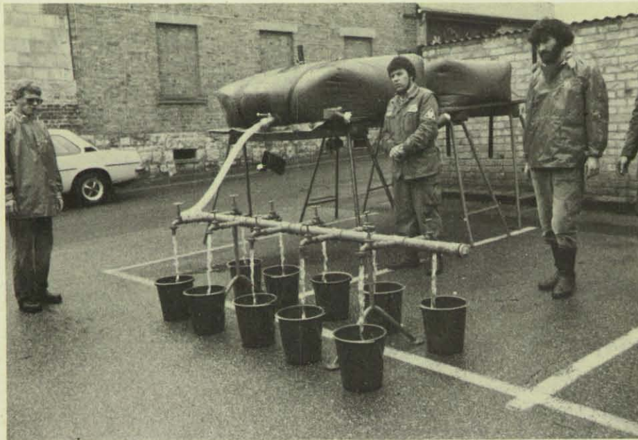
Bild 3: Verteilung von Trinkwasser über eine Gruppenzapfstelle aus transportablen Trinkwasserbehältern, die stationär erhöht auf Gerüstböcken aus Stahlrohr mit untergelegten Kanthölzern gelagert sind.
