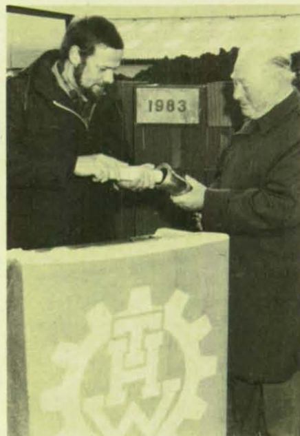
THW-Landesbeauftragter Hans-Albert Lossen legt die Urkunde in den vorbereiteten Metallbehälter. Rechts: THW-Ortsbeauftragter Ulrich Winkler.
