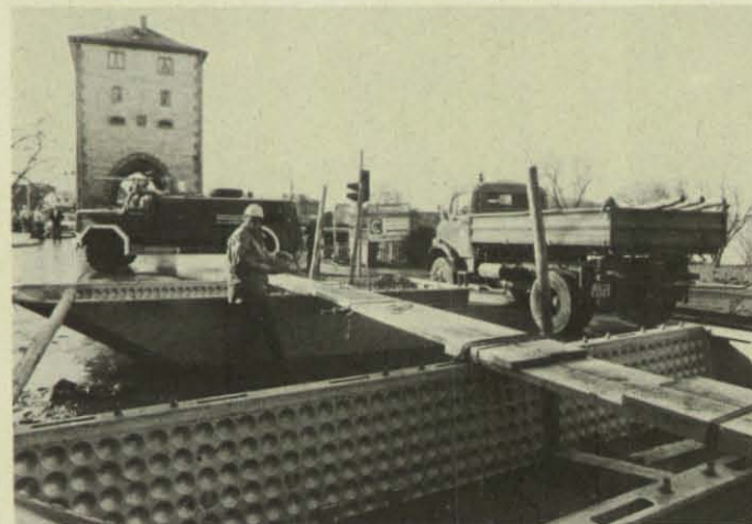
Während die Feuerwehr – wie hier an der alten Brücke in Limburg – den Schlamm von den Straßen spülte, baute das THW seine Stege ab.
