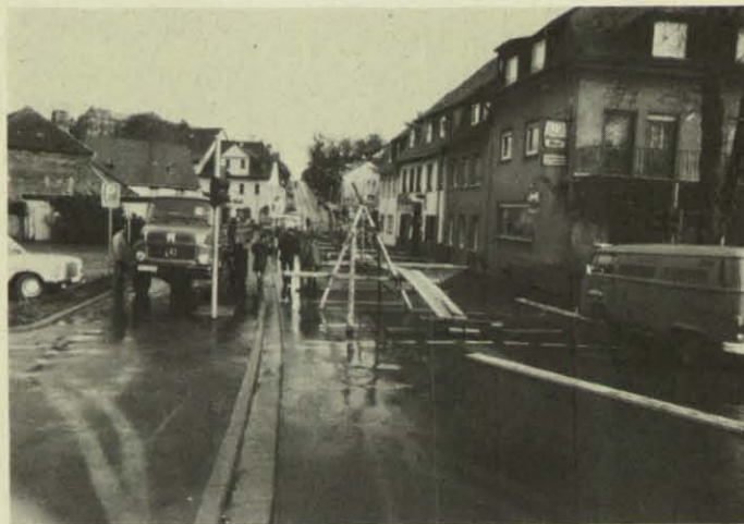
Das THW errichtete mehrere hundert Meter Fußgängerstege.
