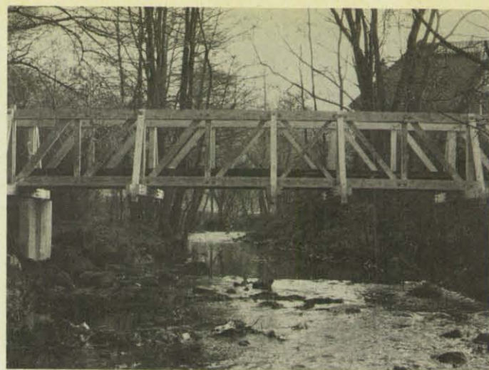
Schmuck sieht die neue Brücke über den Münsterbach aus. (Fotos: Feiber)
