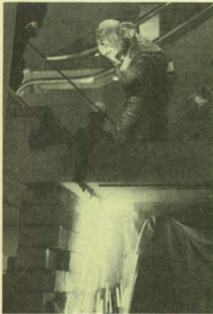
Mit der Sauerstofflanze wird die Betontreppe „abgeschnitten“.
