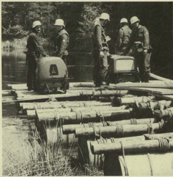
Schon vor Jahren wurden Wasserentnahmestellen angelegt. Kurzfristig baute das THW einen Tonnensteg für die Pumpen.
