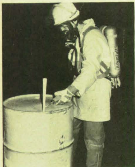
Die Fässer werden provisorisch abgedichtet. (Foto: Krämer)
