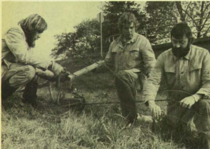
Ölbindemittel-Ölgemische werden unter Verwendung einer aus Maschendraht gefertigten behelfsmäßigen Sperre aufgestaut und können vor der Sperre abgeschöpft werden.
