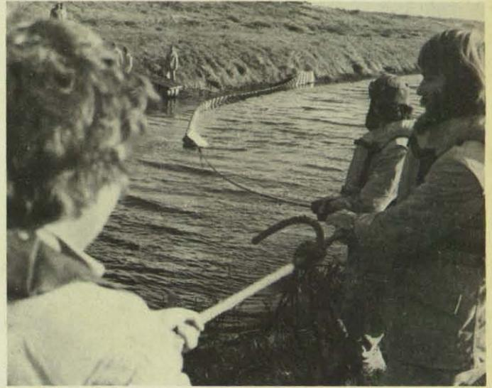
**Oben links:** Vor dem Ausbringen wird die Sperre landseitig durch das Einschlagen von Erdnägeln verankert.
