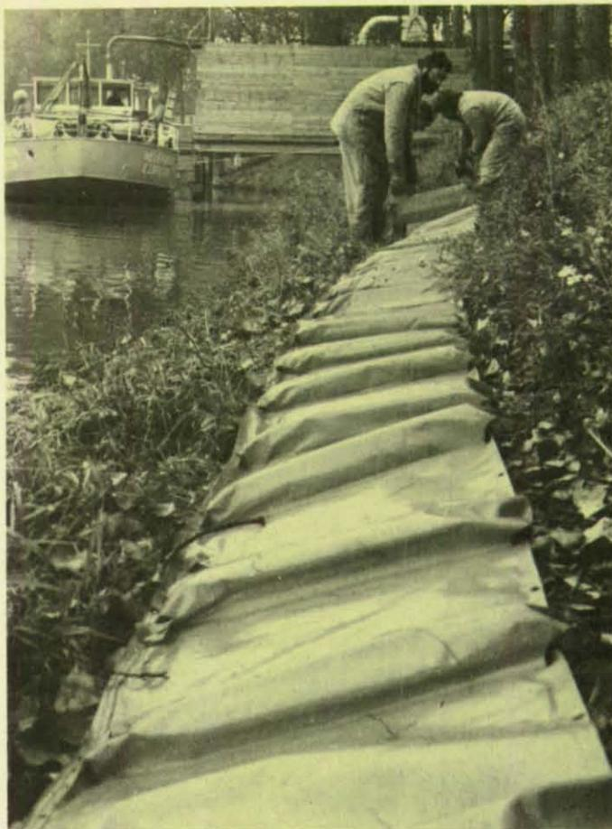
Mit Spezialkupplungsschienen werden Teilstücke der Ölsperre miteinander verbunden.
