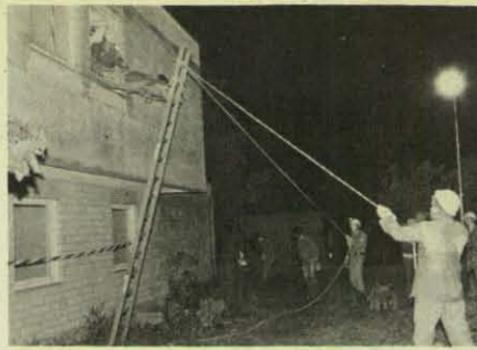
Taghell ist die Schadensstelle ausgeleuchtet. (Foto: Klein)
