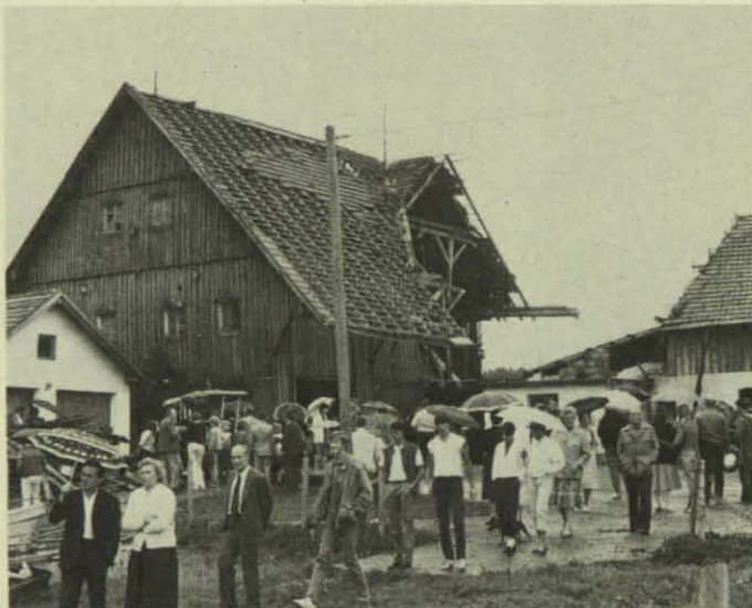
Ein Stück des Dachstuhls und einen Großteil der Ziegel riß das Unwetter mit sich.
