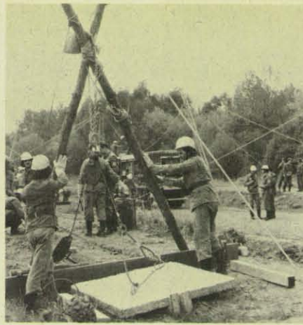
Mit Hilfe des Zweibocks wird die Betonplatte angehoben. (Foto: Winterfeldt)
