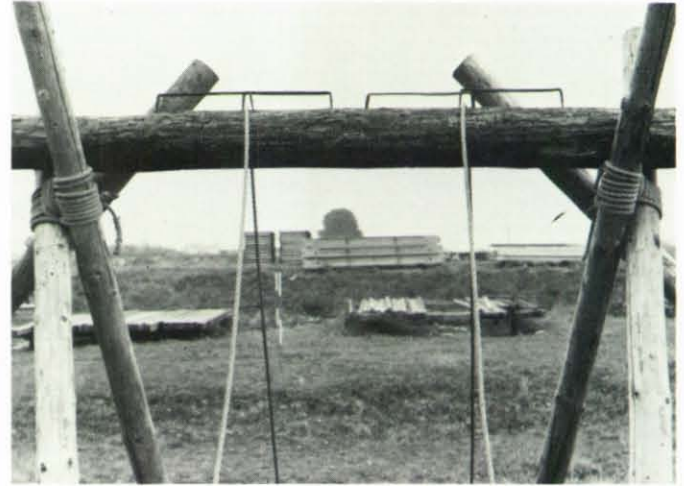
Trageseile sind durch Bauklammern vor seitlicher Verschiebung zu sichern. (Vergl. Abs. 5.4 KatS DV 280)
