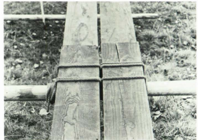
Die Brettafeln werden beim China-Steg im Rechtsverkehr aufgelegt und verbunden – Stolpergefahr –. (Vergl. Abs. 7.3.2 KatS DV 280)
