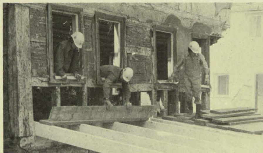
THW-Bergungshelfer sichern ein unter Denkmalschutz stehendes Gebäude.
