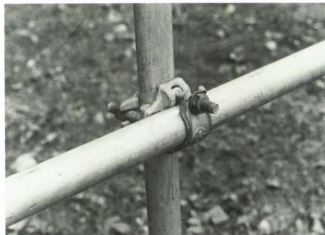
Bei der Verbindung von zwei Rohren mittels einer NKP-Kupplung – Druckbeanspruchung – muß der Bolzen mit Mutter oben sitzen. (Anweisung v. Hersteller)
