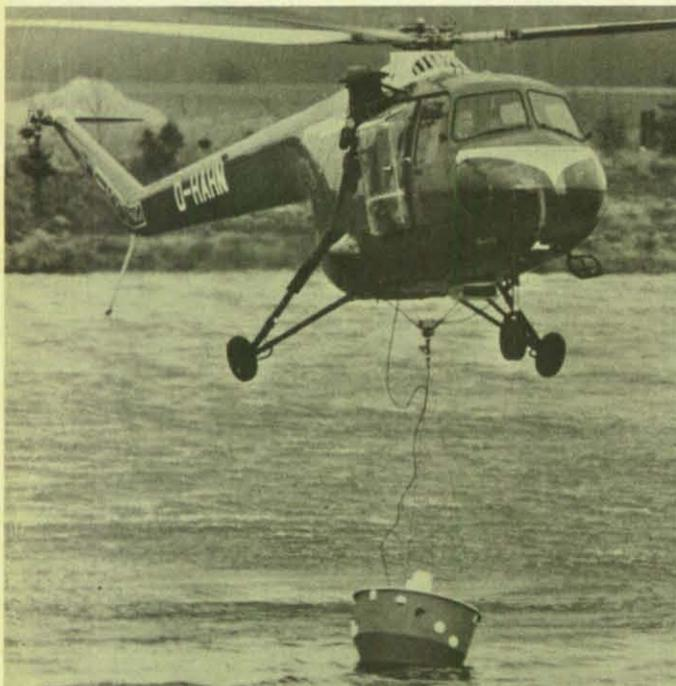
Die Wasserbehälter werden mit einem Lastenkrum am Flugzeug befestigt und in Gewässer getaucht, so daß sie sich füllen.
