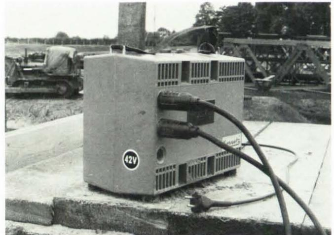
Für das Lichtbogenschweißen unter erhöhter elektrischer Gefährdung dürfen nur entsprechend gekennzeichnete Schweißstromquellen verwendet werden. Hier 42 Volt Leerlaufspannung. (§ 28)
