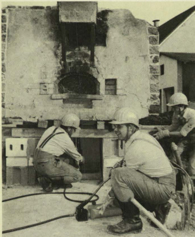
Mit Hydraulikhebern des Gerätewagens wird der Backofen angehoben. (Foto: Elmer)
