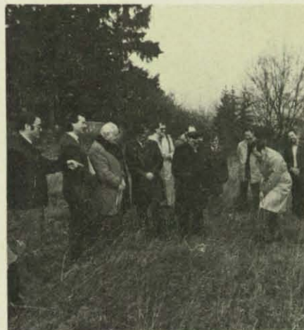
Beim ersten offiziellen Spatenstich durch den Landrat des Landkreises Marburg-Biedenkopf, Dr. Christian Wagner
