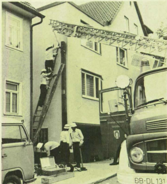
Auch das gehört zu den Aufgaben der Feuerwehr: Eine einbruchgefährdete Hauswand wird abgestützt. (Fotos: Sers, DRK, MHD, Hilberath, DLRG)
