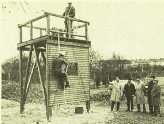
Der neue Übungsturm in Bremerhaven.
