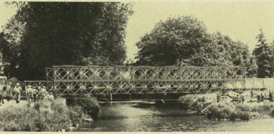
Rund 70 THW-Helfer sind beim Bau der Bailey-Brücke eingesetzt.
