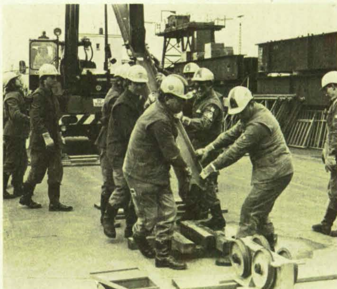
Oben: Hoher Besuch beim THW (v. l.): Bundesminister Dr. Schäuble, Landtagsabgeordneter Felix Hodapp, THW-Mitarbeiter Gerd Krüger, THW-Ortsbeauftragter Wolfgang Ertel. Links: Das Teil einer Hauptträgerwand wird mit Hilfe eines Krans auf den Zweirollenkasten aufgesetzt. (Fotos: Dölker)
