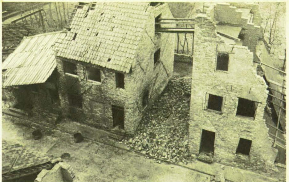
Ein 50000 qm großes Übungsgelände mit vielen Schadenselementen steht für eine realistische Ausbildung zur Verfügung.
