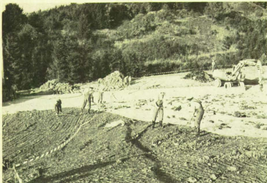
Um ein weiteres Abrutschen der Müll- und Erdmassen zu verhindern, wird auf einer Breite von 40 Metern eine Kunststoffolie verlegt.
