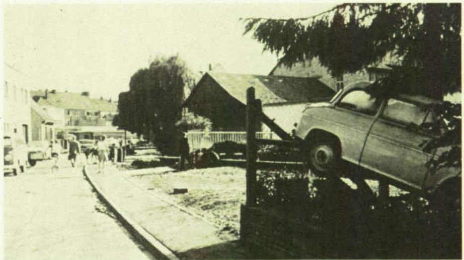
Folgen des Katastrophenhochwassers am Eipbach im Juli 1970 in Eitorf.
