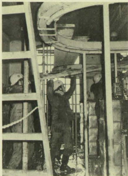
Schwierig gestaltet sich das Abstützen der Geschoßdecke. (Foto: Lillich)
