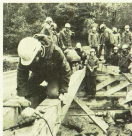
In einem zwölfstündigen Einsatz bauen die THW-Helfer eine Holzbrücke. (Foto: Herrmann)
