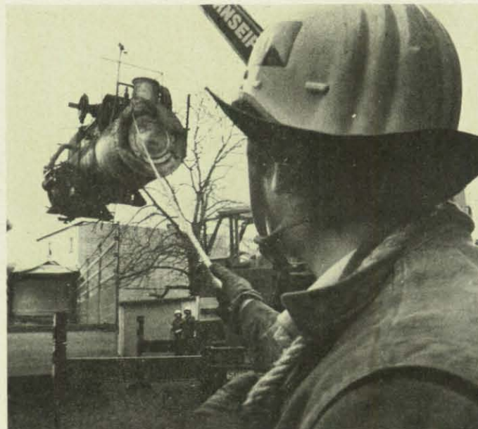
Das schwerste Stück Arbeit ist geschafft. Jetzt gilt es, die zwölf Tonnen schwere Dampfmaschine auf den Sattelzug zu plazieren. (Foto: Lück)
