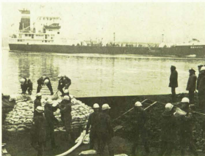
Die THW-Bergungshelfer beim Einbau der Sandsäcke.
