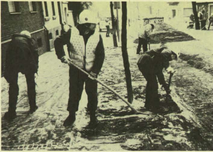
Bevor die Straße mit dem Dampfstrahlgerät gereinigt werden konnte, mußte zuerst das Sand-Bindemittel-Ölgemisch mit Schaufeln abgetragen werden.
