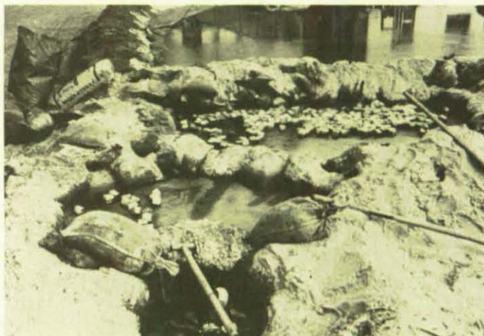
Aus Sandsäcken und Sand bildeten die Helfer eine Ölsperre, woraus das Öl später abgepumpt wurde.
