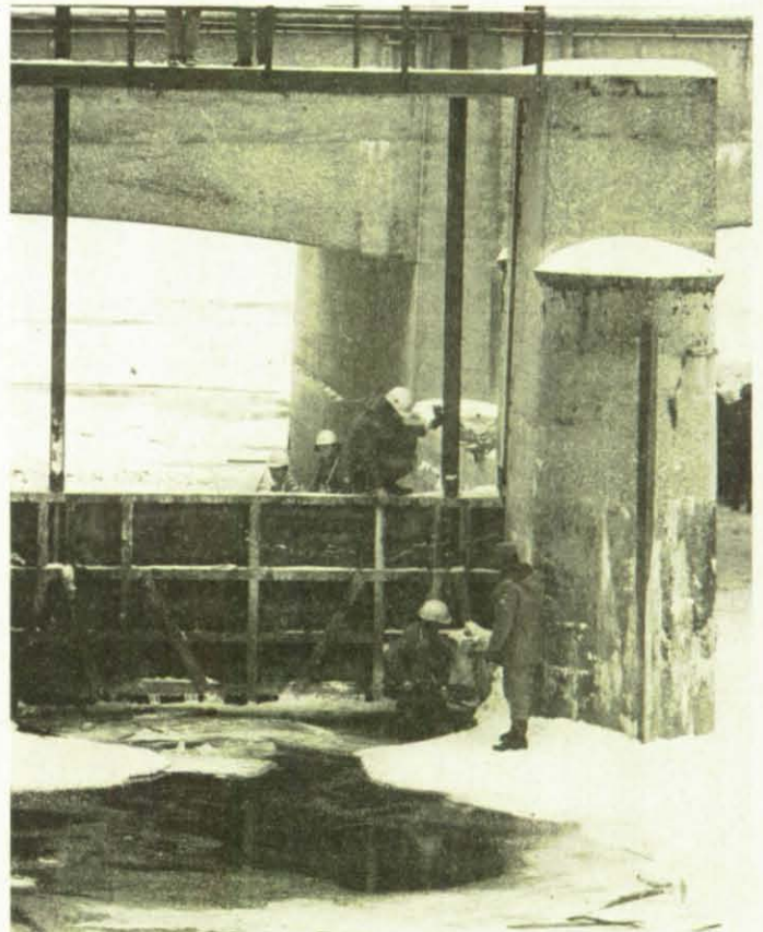
Um die Funktionsfähigkeit einer Wehranlage zu gewährleisten, wird das Eis entfernt. (Foto: Pfitzmeier)
