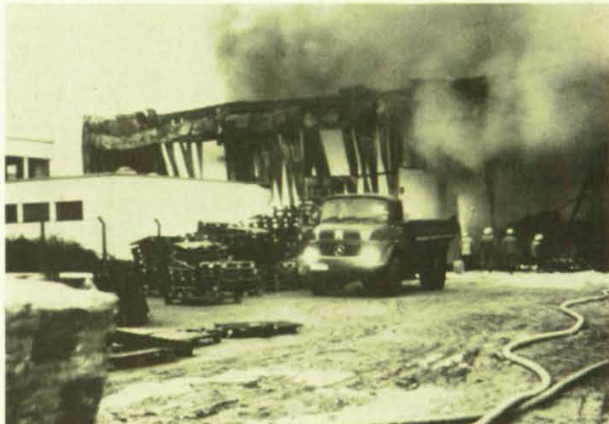
Die in Brand geratene Lagerhalle der Mineralölfirma.
