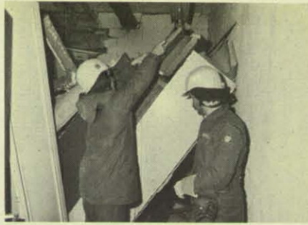
25 THW-Helfer sind an den Bergungsarbeiten in der Bank beteiligt.
