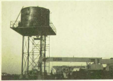
Montage eines stählernen Wasserturmes in einem sudanesischen Dorf.
