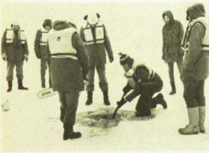
Mit einer Axt und der Motorsäge werden Sprenglöcher hergestellt. (Foto: Nagel)
