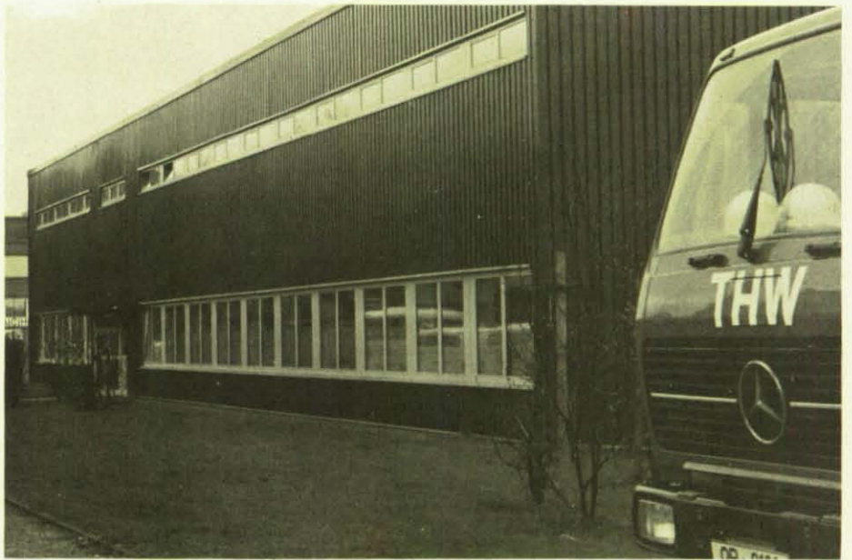
Das Unterkunfts- und Lagergebäude. Auch Schulungs- und Werkräume sind hier vorhanden.
