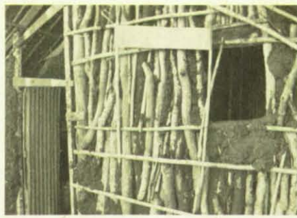
Ein großer Fortschritt: Das neue Hospital in Yabbus – 45 Quadratmeter aus Holz und Lehm. Pro Tag werden hier rund 60 Patienten versorgt. (Fotos: JUH)
