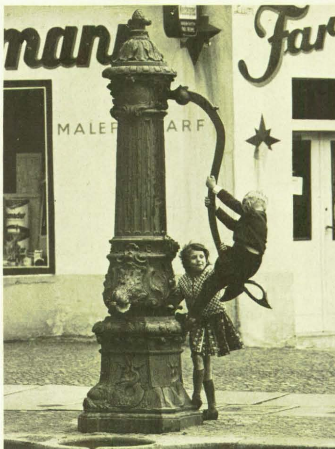
Bild 1: Berliner Straßenbrunnen aus der „guten alten Zeit“ mit reich verziertem gußeisernem Brunnenständer zur Trinkwasser-Notversorgung.
