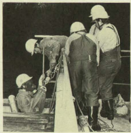
Ein gesicherter THW-Helfer steigt in den Schlammbehälter. (Foto: Elmer)
