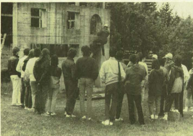
Das THW demonstrierte, wie Personen in Rettungsgurten in oberen Stockwerken geholt werden können.
