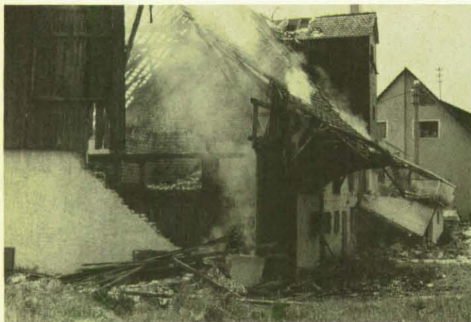
Ein zerstörtes Gebäude als Schadensdarstellung.
