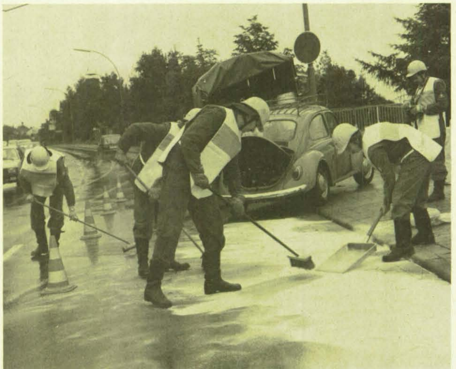
Mit Bindemittel versuchen die Einsatzkräfte, die Ölsuren auf Verkehrsflächen zu beseitigen. (Fotos: Hilberath [2], Feuerwehr München)
