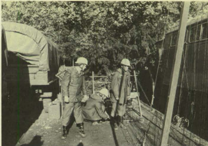
Ein Fernsprechtrupp beim Verlegen von Feldkabel.
