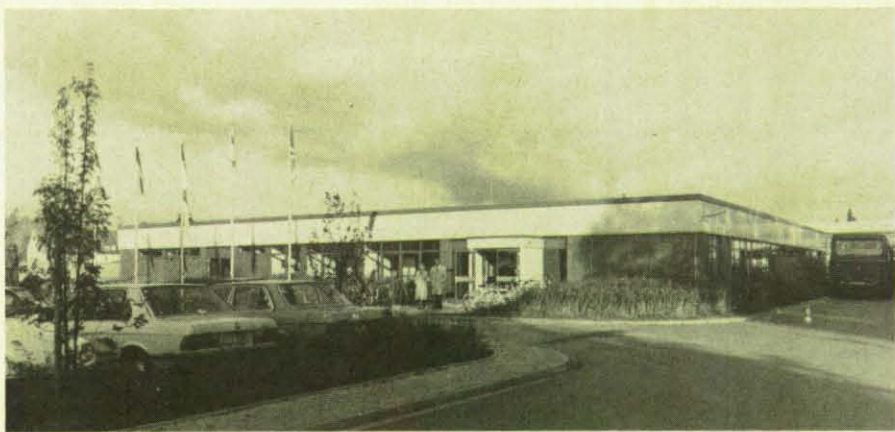
Blick auf den Verwaltungstrakt der neuen Unterkunft.
