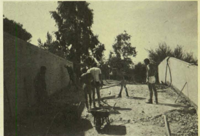
Vorbereiten des Untergrundes für den Bau eines Arbeitsraumes auf dem Friedhof.
