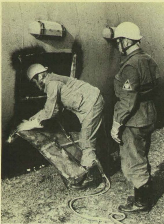
Links: Mit dem Schneidbrenner wird ein Loch in das Wagendach geschnitten.
