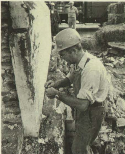
Oben: Letzte Vorbereitung für die Sprengung.
