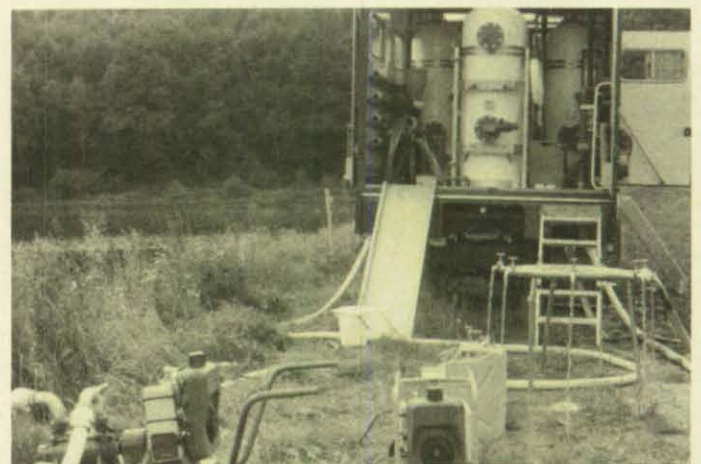
Bild 6: Mobile Trinkwasser-Aufbereitungsanlage (Heckansicht vom Kastenaufbau) mit aufgestellter Rohwasserförderpumpe, Eigenstromerzeuger und Trinkwasser-Verteilerring mit Wasserhähnen in Betrieb.
