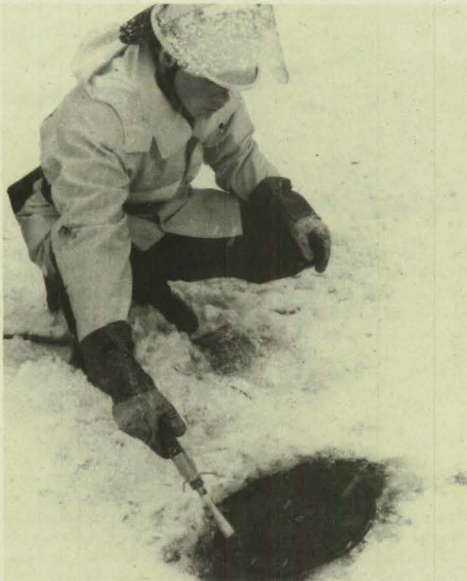
Bild 6: Gute Dienste leistet im Winter ein Propangas-Brenner, wenn vereiste Unterflurhydranten geöffnet werden müssen.
