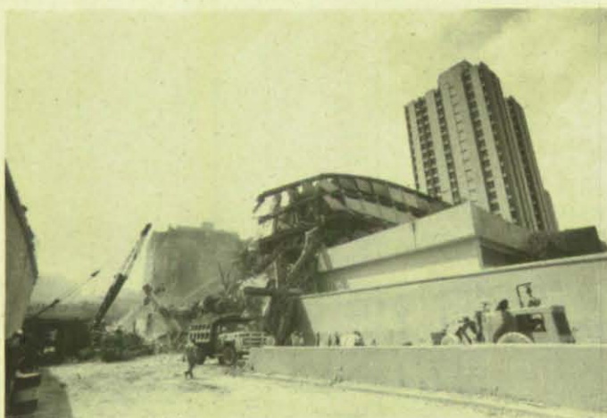
Eingestürzte Gebäude wie dieses Hochhaus in Mexiko-City waren Anlaß für die Entsendung bundesdeutscher Bergungshelfer.
