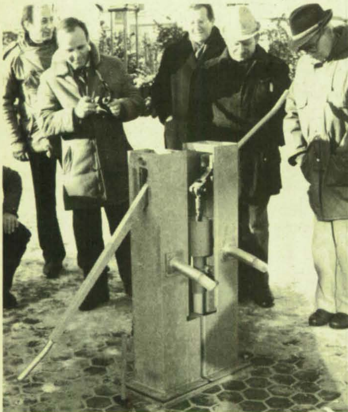
Bild 10: Zwillingshandpumpe mit den beiden aufgesetzten Pumpengehäusetellen.
