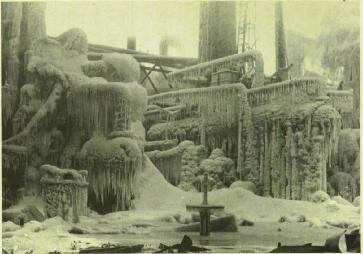
Bild 7: Nach einem Löscheinsatz der Feuerwehr. Das Bild verdeutlicht ganz besonders die Probleme, mit denen die Feuerwehr im Winter zu kämpfen hat.
