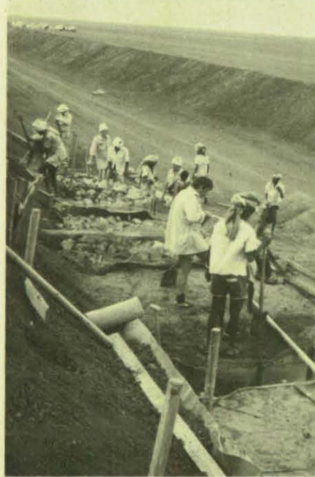
Unter tatkräftiger Mithilfe der Bevölkerung bauen THW-Helfer eine Trinkwasser-Aufbereitungsanlage im Sudan.
