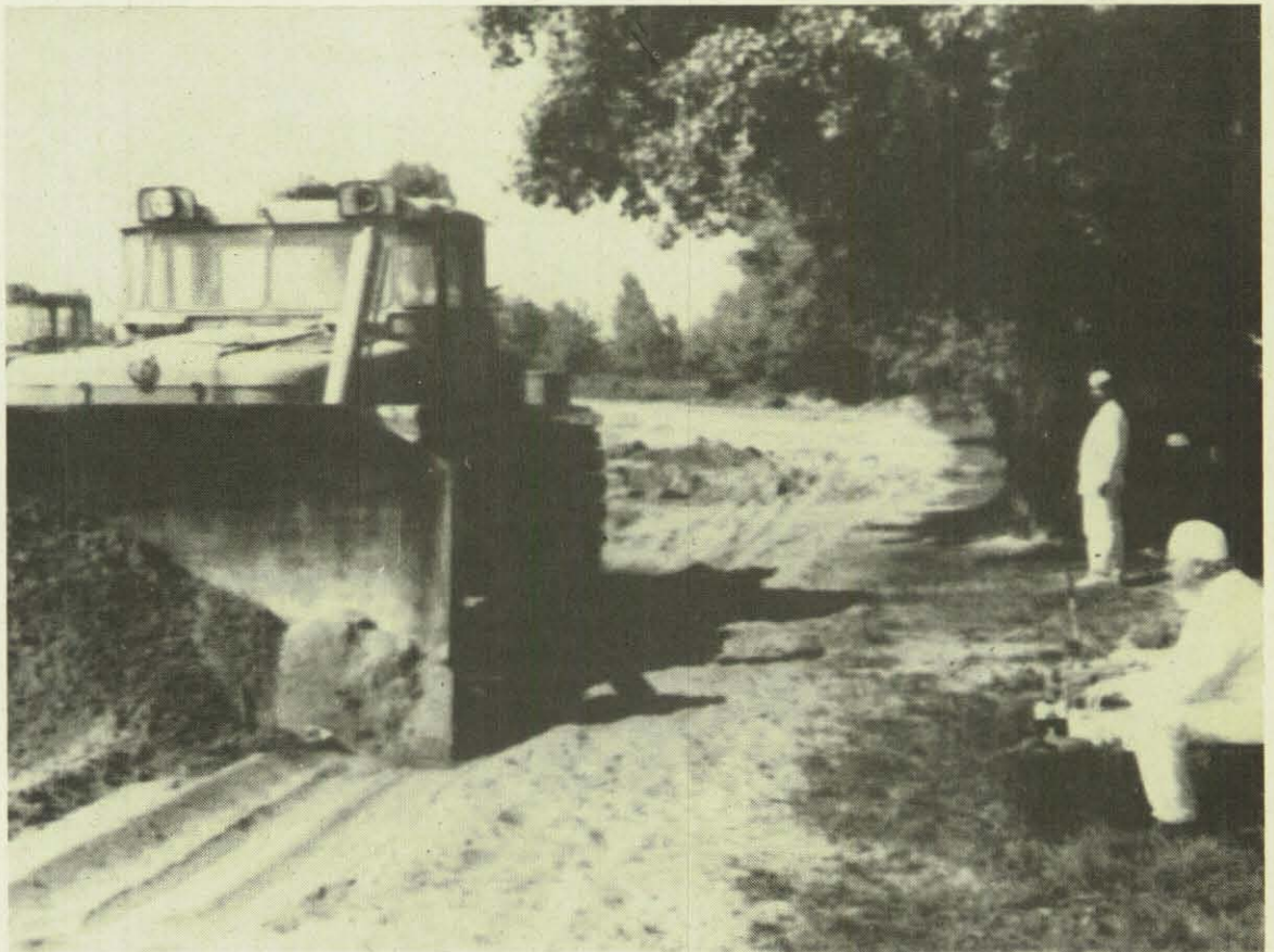
Mit ferngesteuerten Bulldozern wurden radioaktiv verseuchte Erdschichten in der Nähe des Reaktors abgetragen.
