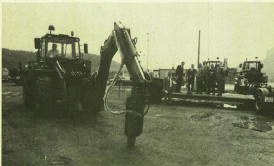
Demonstration des Räumgerätes mit dem Hydraulikbohrvorsatz.
