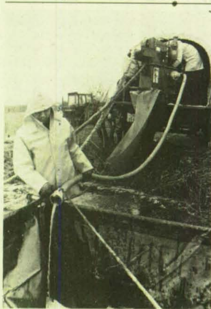
Unten: Fast 3 000 Liter Heizöl konnten mit dem „Skimmer“ abgefischt werden. Fotos: Behrens
