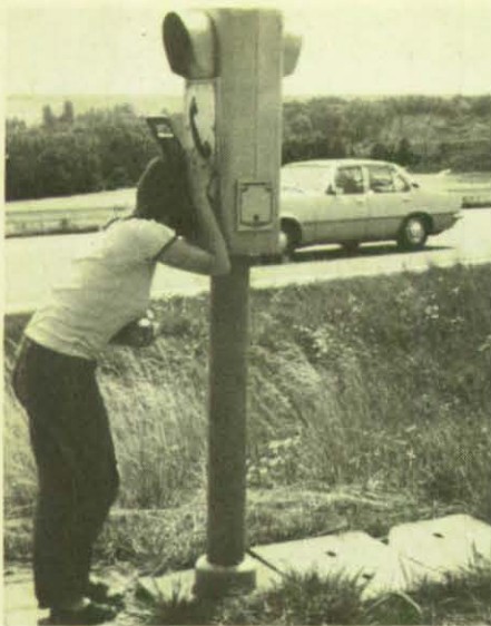
Links: Eine Notrufsäule an einer Bundesautobahn.
