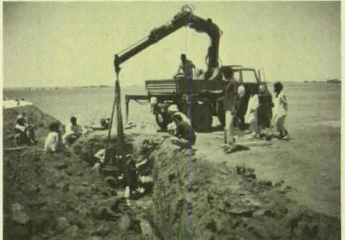
**Das Ponton zur späteren Aufnahme der Pumpe wird eingebracht.**
