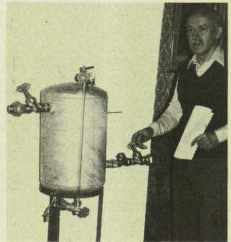
Der Behälter wird in die Wasserversorgung eines Gebäudes eingebaut und so ständig von Frischwasser durchflossen. Bei einer Unterbrechung der Versorgung steht dann der gesamte Behälterinhalt als Trinkwasserreserve zur Verfügung. Ein Rückschlagventil verhindert bei ausbleibendem Wasserdruck ein Leerlaufen des Behälters. Mittels eines Wasserstandsanzeigers läßt sich die noch vorhandene Wassermenge im Behälter feststellen.
