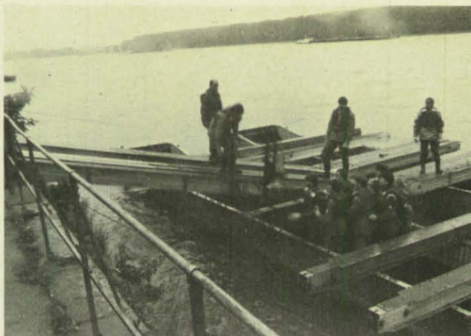
Die Pontongruppe beim Bau des Anlegers.
