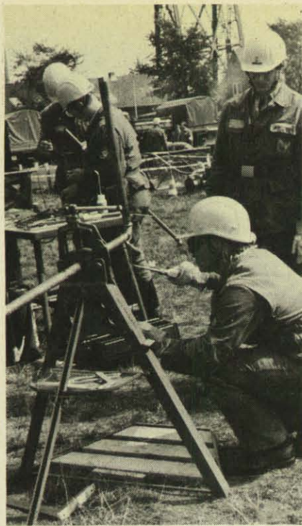
Rohrarbeiten für den Anschluß einer Behelfswaschanlage. (Foto: Voß)
