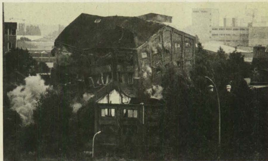
Gekont wird das alte Fabrikgebäude gesprengt.
