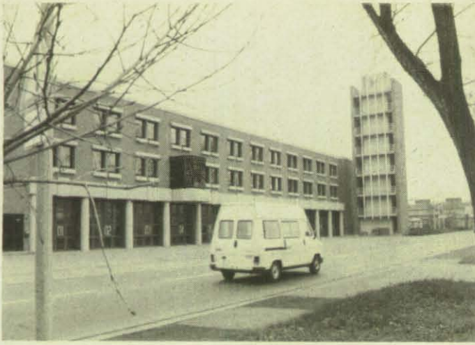
Das Katastrophenschutzzentrum der Stadt am Margaretendamm.
