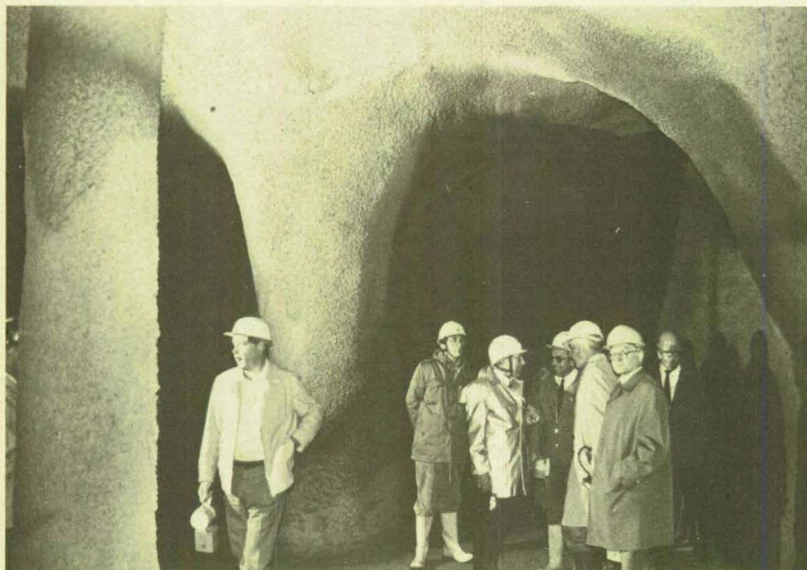
Ein sanierter Felsenkeller. Mit dem Torcretierungsverfahren wurde das Gebirge vor Nachbrüchen geschützt.
