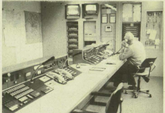
Die Einsatzleitstelle der Ständigen Wache der Feuerwehr.
