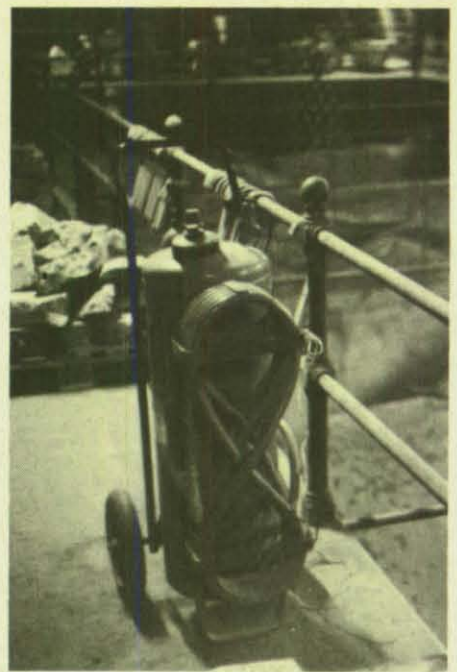
Acht fahrbare Pulverlöscher mit je 50 Kilo Löschpulver sind über den Dachboden verteilt. (Fotos: Claes [10], Gaertner)
