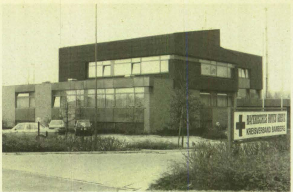
Eine der modernsten Rettungsleitstellen in Bayern hat das BRK am Rande der Stadt gebaut.
