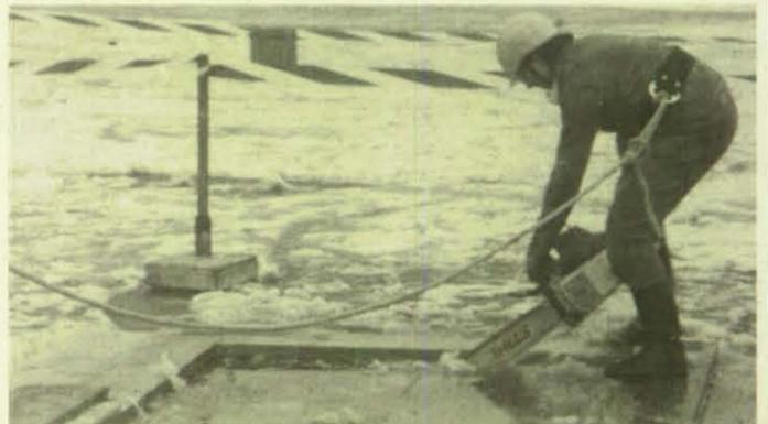
möglicht, mit der Motorsäge ein Durchbruch für den Ein- und Ausstieg der Taucher hergestellt.
