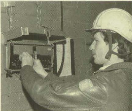
Ein THW-Helfer beim Verdrahten der Leitungen am Blitzschutzkasten. (Foto: Siebke)
