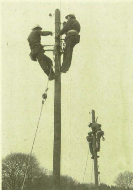
Eine der Wettkampfaufgaben: Arbeiten an einer Freileitung.
