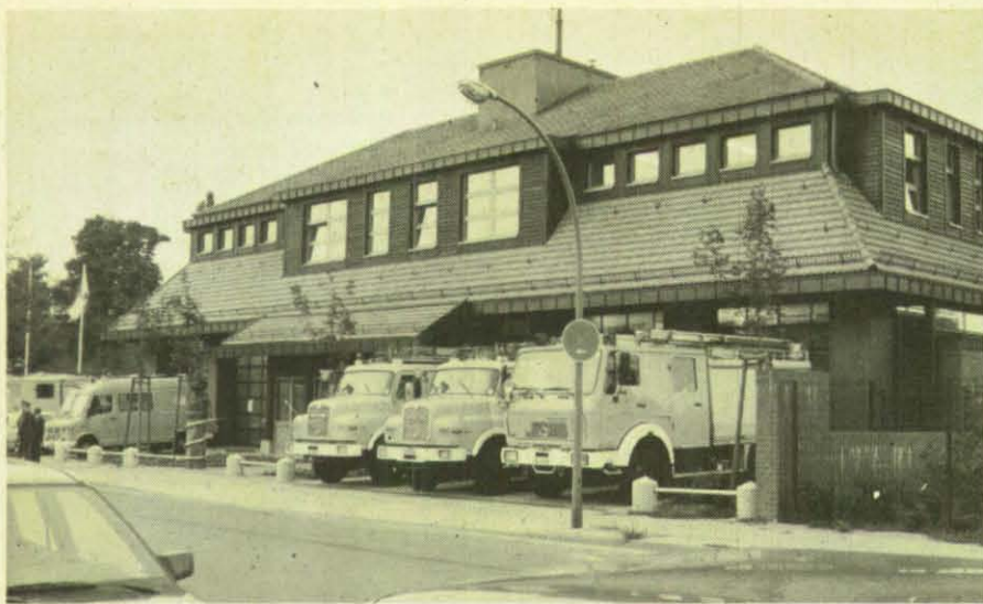
Allen Anforderungen an eine moderne Feuerwache wird das neue Gebäude in Lichtenrade gerecht.
