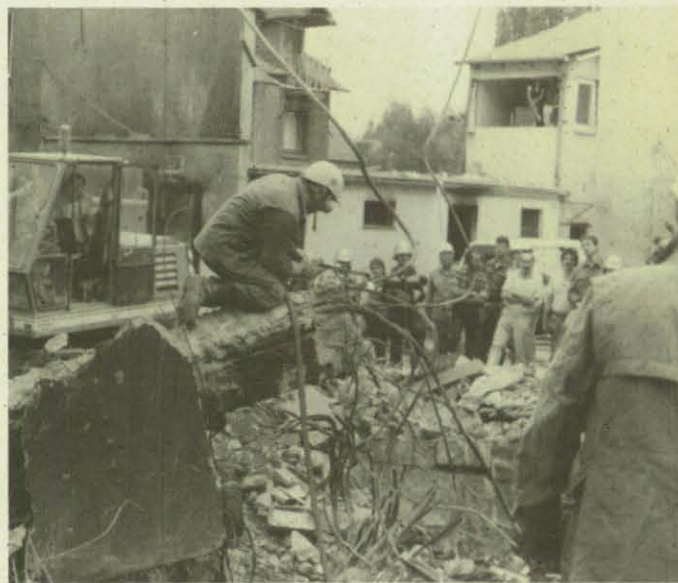
Mit dem Brennschneidergerät müssen die zerborstenen Stahlbetonträger voneinander gelöst werden.
