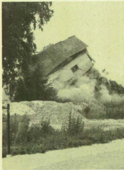
Maßarbeit: Das Gebäude fällt in sich zusammen (Foto: Bockstiegel)
