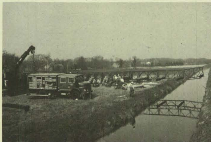
Die vormontierte Brücke mit Vorbau-schnabel.
