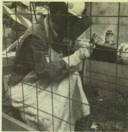
Eine der Wettkampfaufgaben ist das Schweißen einer Wasserleitung. (Foto: Höge)
