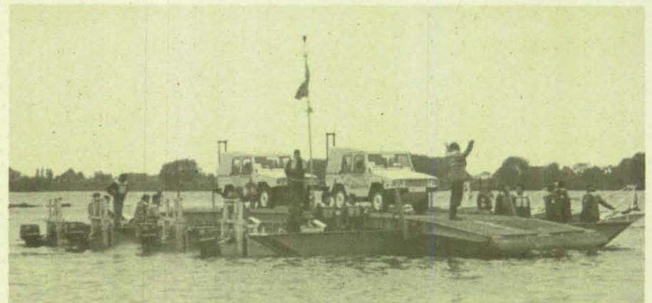
Die THW-Pontonfähre beim Übersetzen von DRK-Einsatzfahrzeugen
