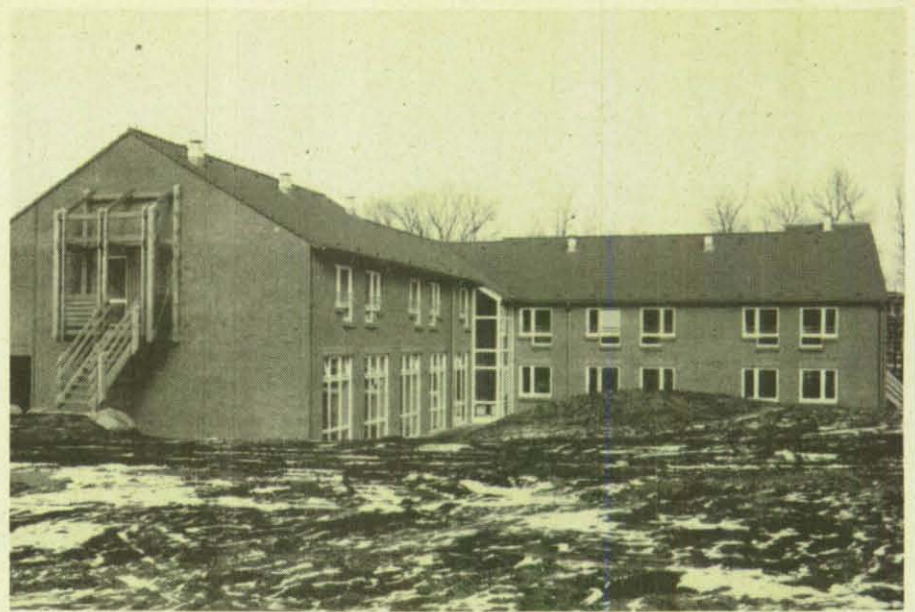
Oben: Die Rückansicht des neuen Gebäudeteils vom DLRG-Landesjugend- und Schulungsheim mit einer der beiden Nottreppen.
