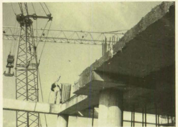
**Bild 4: ... und einer Fahrbahnplatte.**
