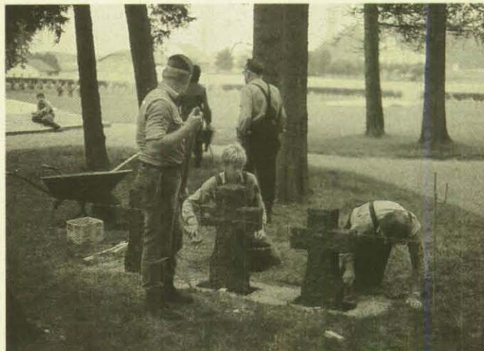
66 Basaltlavakreuze werden in feste Betonfundamente verankert.
