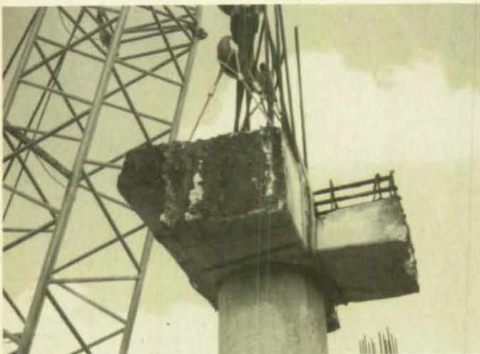
**Bild 3: Abbruch eines Stahlbetonpfeilers ...**
