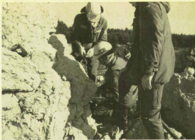
Unter fachmännischer Leitung erfolgt die Vorbereitung zur Sprengung.
