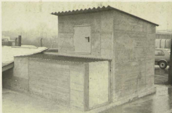
Ansicht der Übungseinrichtung: Brandübungshaus, Trümmergang und Rutschfläche. (Foto: Woltemath)
