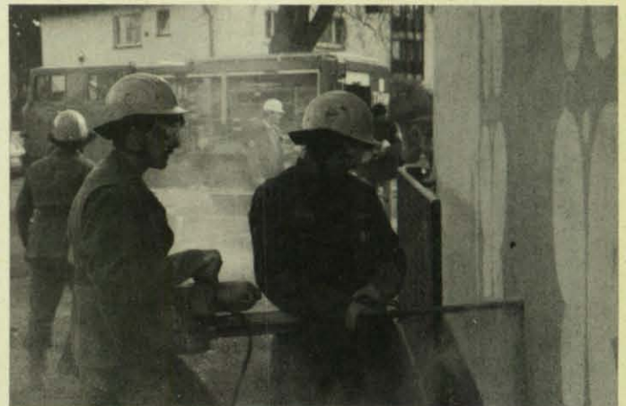
Als Zugang zum Gebäude müssen Mauerdurchbrüche geschaffen werden. (Foto: Maisch)
