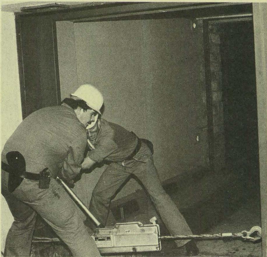
Verschluss des Einfahrtstores mit einem Greifzug.
