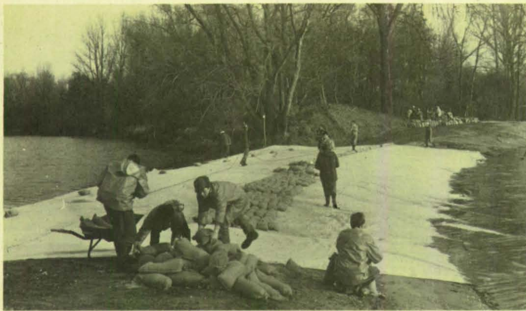
Insgesamt müssen 3000 Sandsäcke zwischen den beiden Seen verlegt werden.
