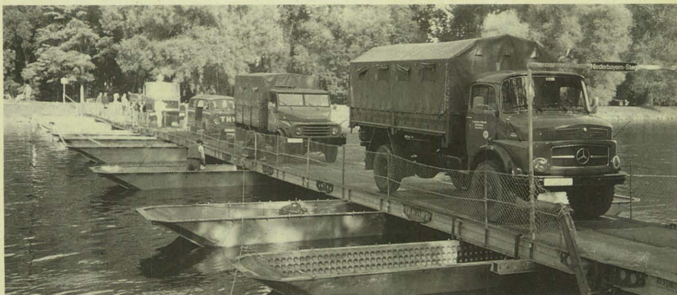
Der „Niederbayern-Steg“ wird durch THW-Fahrzeuge einer Belastungsprobe unterzogen.
