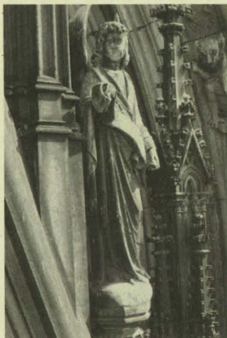
Die Engelsdarstellung (links) ist durch Umwelteinflüsse bereits weitgehend zerstört, die aus geeigneterem Material geschaffene Neuanfertigung (rechts) wird den schädlichen Einwirkungen besser widerstehen können. (Fotos: Hilgers)
