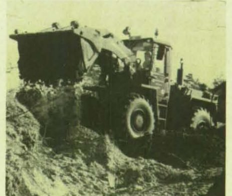
Mit der Mehrzweckschaufel wird eine Rampe angelegt.
