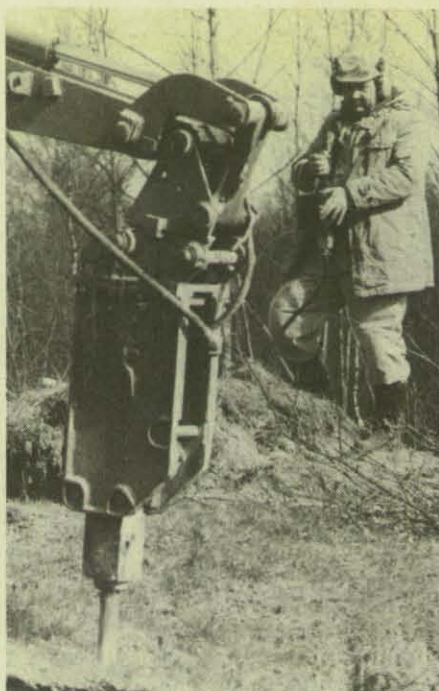
Ein Lehrgangsteilnehmer steuert über die Fernbedienung den Aufbruchhammer. Hier die vertikale Hammerführung.
