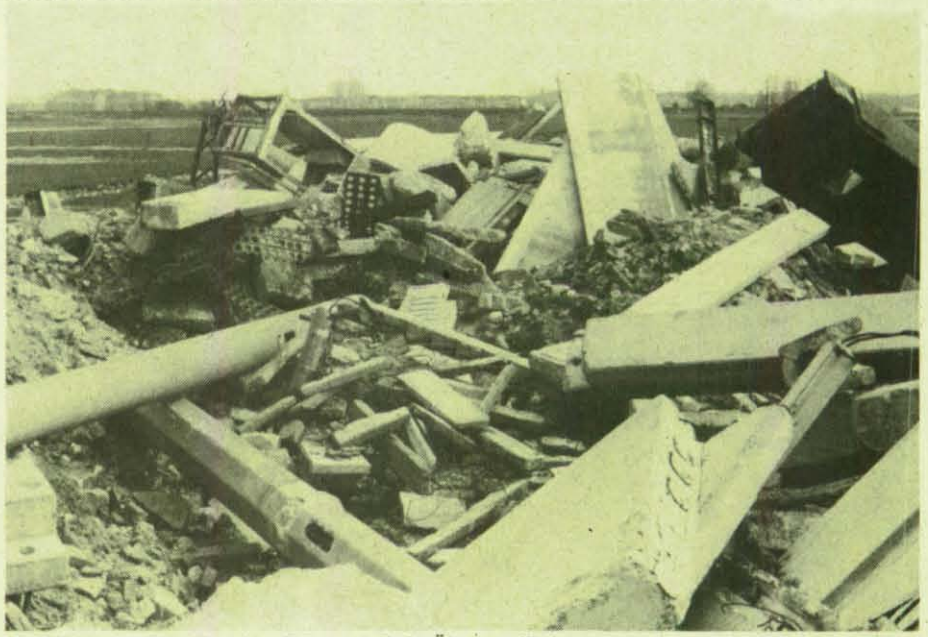
Großflächige und mittelbrockige Trümmerteile im Übungsgelände.
