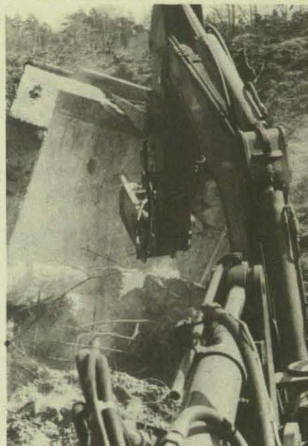
Die horizontale Hammerführung an einer Bunkerwand.
