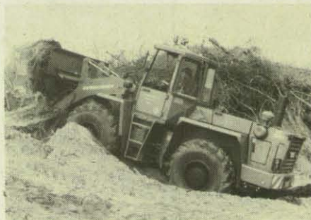
Arbeiten mit der Schaufel am Hang.
