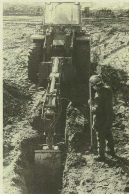
Mit dem Zweischalengreifer ist im weichen Sandboden schnell ein Rohrgraben ausgehoben.
