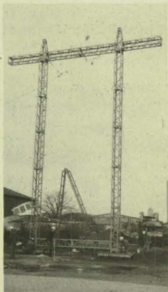
Das Portal ist errichtet. Es fehlen noch die Isolatoren. (Foto: Profrock)
