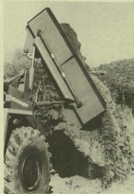
Arbeiten mit der Seitenkippschaufel.
