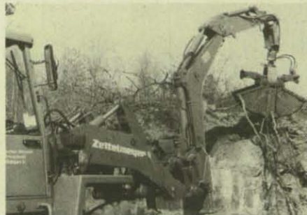
Der Einsatz des Zweischalengreifers über Niveau: Freilegen eines Bunkers.
