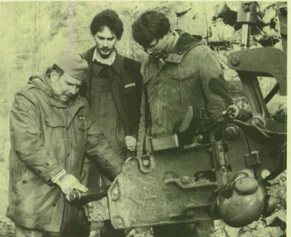
Wie wird der Meißel ausgewechselt? Was ist bei der Hammerschmierung zu beachten? Unterricht am Objekt.
