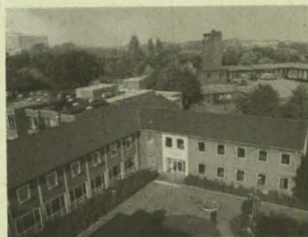
Ein Blick auf das weitläufige Gelände der Landesfeuerwehrschule zeigt Verwaltungs- und Lehrsaaltrakt (im Vordergrund) sowie Steigturm und Fahrzeughallen (im Hintergrund).
