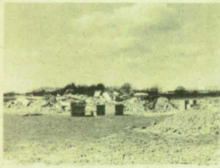
Das Trümmergelände der KSB-Außenstelle Hoya.
