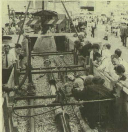
Der Instandsetzungsdienst des THW demonstriert, wie beschädigte Versorgungsleitungen repariert werden.
