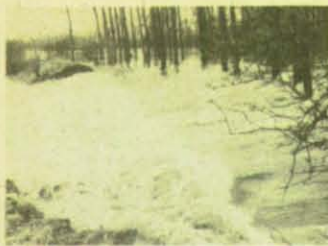
Ein 100 Meter breiter Riß klappte im Damm bei Niederachdorf.
