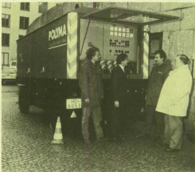
Mit der 175-kVA-Netzersetzanlage aus Hof vor dem Maximilianeum in München (v. links): Gruppenführer Degelmann, der Hofer Landtagsabgeordnete Hering, Gruppenführer Köppel und Hauptsachgebietsleiter Schelzig vom THW-Landesverband.
