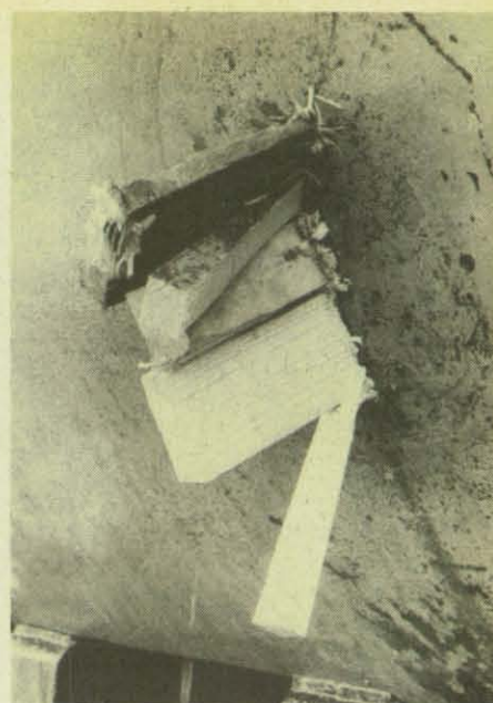
Schnelle Hilfe ist auch möglich, wenn Holzkeile in die Rißstelle eingetrieben werden.
