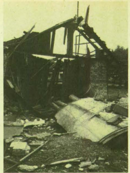
Von den umliegenden Gebäuden auf dem Grubengelände blieben nur noch die Grundmauern stehen.
