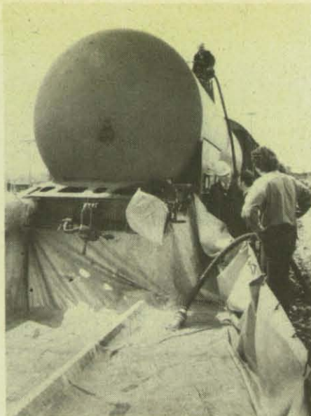
Eine druckluftbetriebene Pumpe pumpt das aufgefangene Ladegut in den Kessel zurück, wenn kein leerer Kesselwagen bereit steht.
