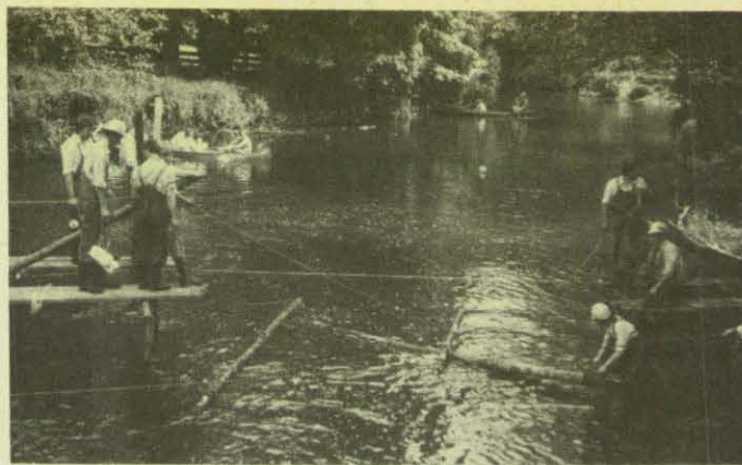
Der letzte Zweibock wird aufgerichtet, bald ist die Verbindung von Ufer zu Ufer hergestellt. (Foto: Pröfrock)
