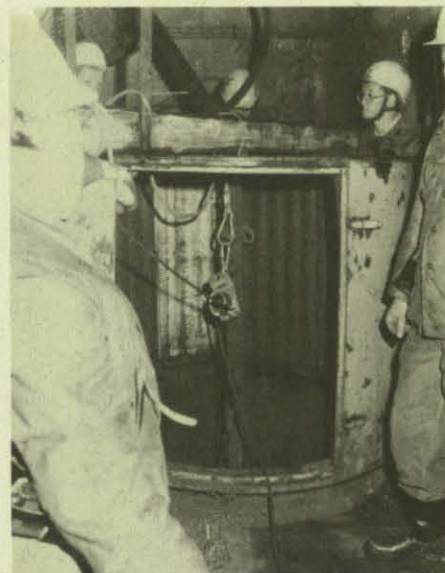
Mit dem Rollgliss-Gerät werden die ersten Rettungsmannschaften durch den Wetterschacht nach unten abgeseilt.
