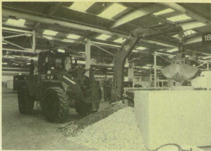
Das Bergungsräumgerät leistet beim Aufbau des Rohrgrabenstückes wertvolle Hilfe.
