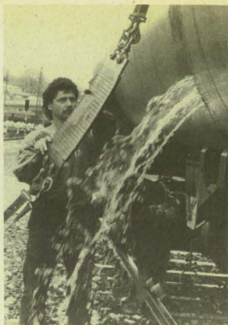
Hilfsmittel zum Abdichten einer Rißstelle ist das pneumatische Dichtkissen.
