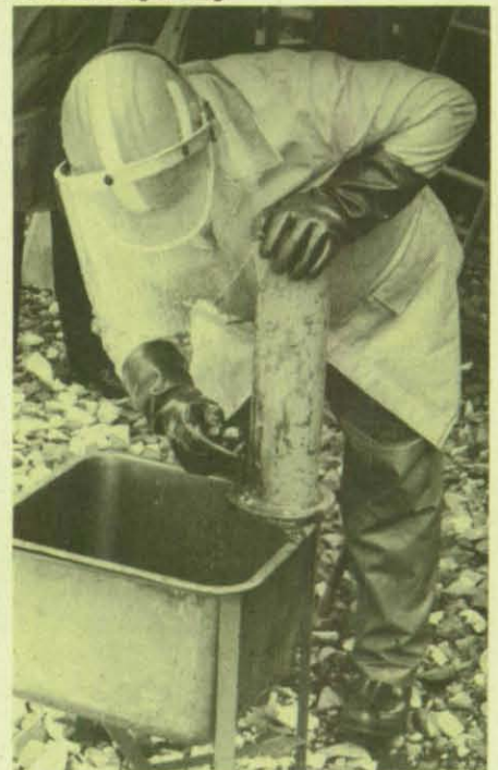
Ein Mitarbeiter des Lehrhilfszugs demonstriert, wie kleine Risse mit Hilfe von Dichtstiften abgedichtet werden können.
