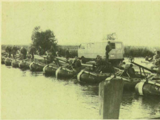
Behelfsmäßiges Übersetzen von Einsatzkräften und Einsatzmitteln.
