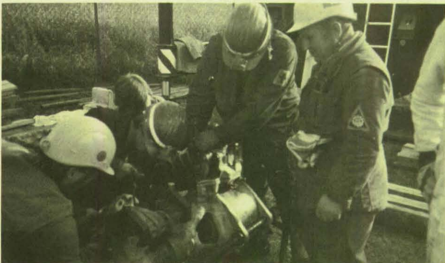
Grubenwehr und THW-Helfer arbeiten Hand in Hand.
