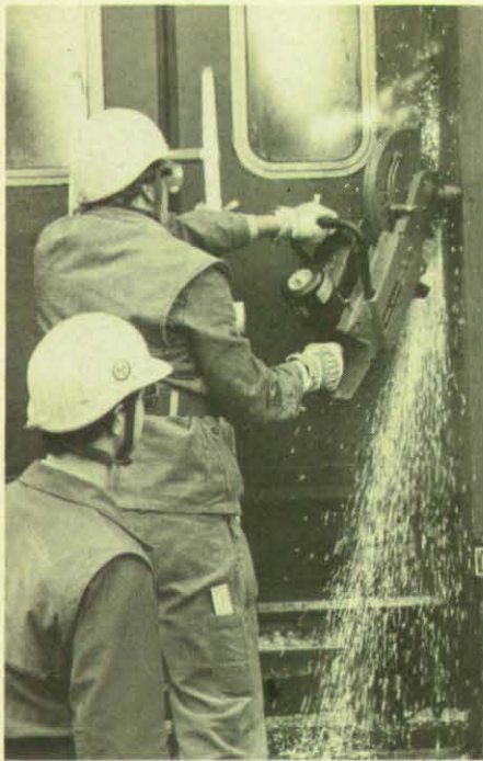
Mit dem Motortrennschleifer ist schnell ein Zugang geschaffen.
