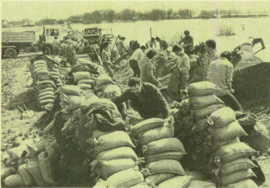
Zahlreiche freiwillige Helfer unterstützen den Bau eines Hilfsdamms bei Niederachdorf.
