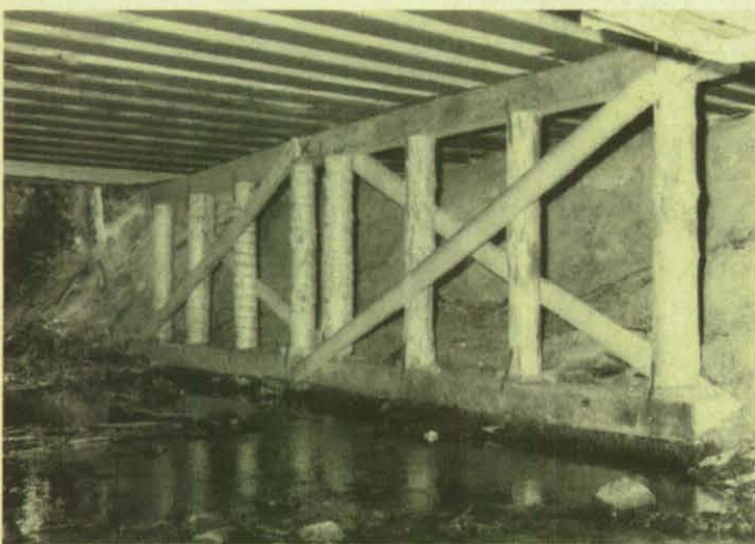
Mit einer aufwendigen Balkenkonstruktion wird die Brücke abgesichert.
