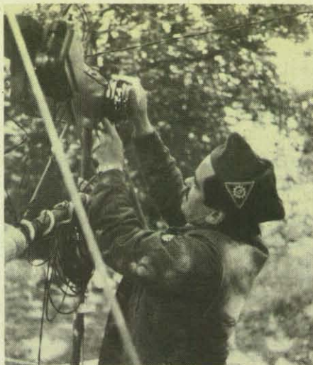
Eine der Aufgaben ist das Einrichten von Feldfernsprechleitungen.
