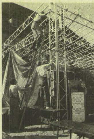
THW-Helfer beim Aufbau einer Bühnenüberdachung.
