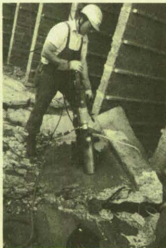
Das Kernbohrgerät im Einsatz. (Foto: Klingenberg)
