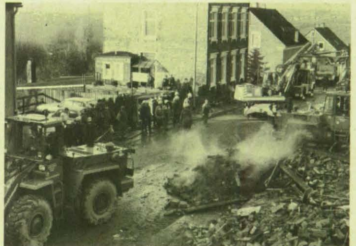
Die Bergungsräumgeräte des THW lassen sich hier wirkungsvoll einsetzen. (Fotos: Claes)
