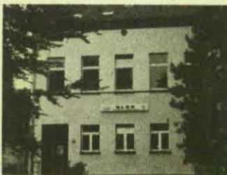
Die neue Ausbildungs- und Einsatzzentrale.
