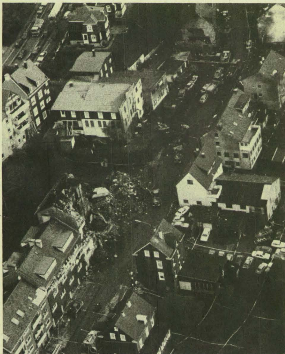
Blick auf die Stockder Straße, die Zerstörungen sind deutlich zu erkennen.
