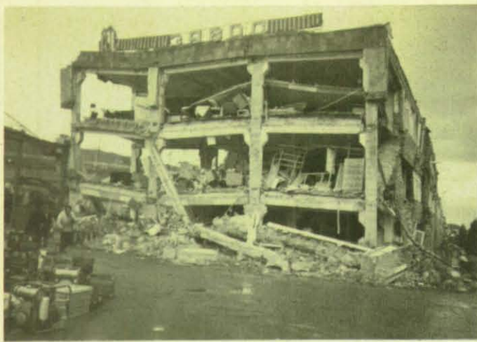
Eindrucksvoll zeigt dieses Foto die Zerstörungen durch das Erdbeben.
