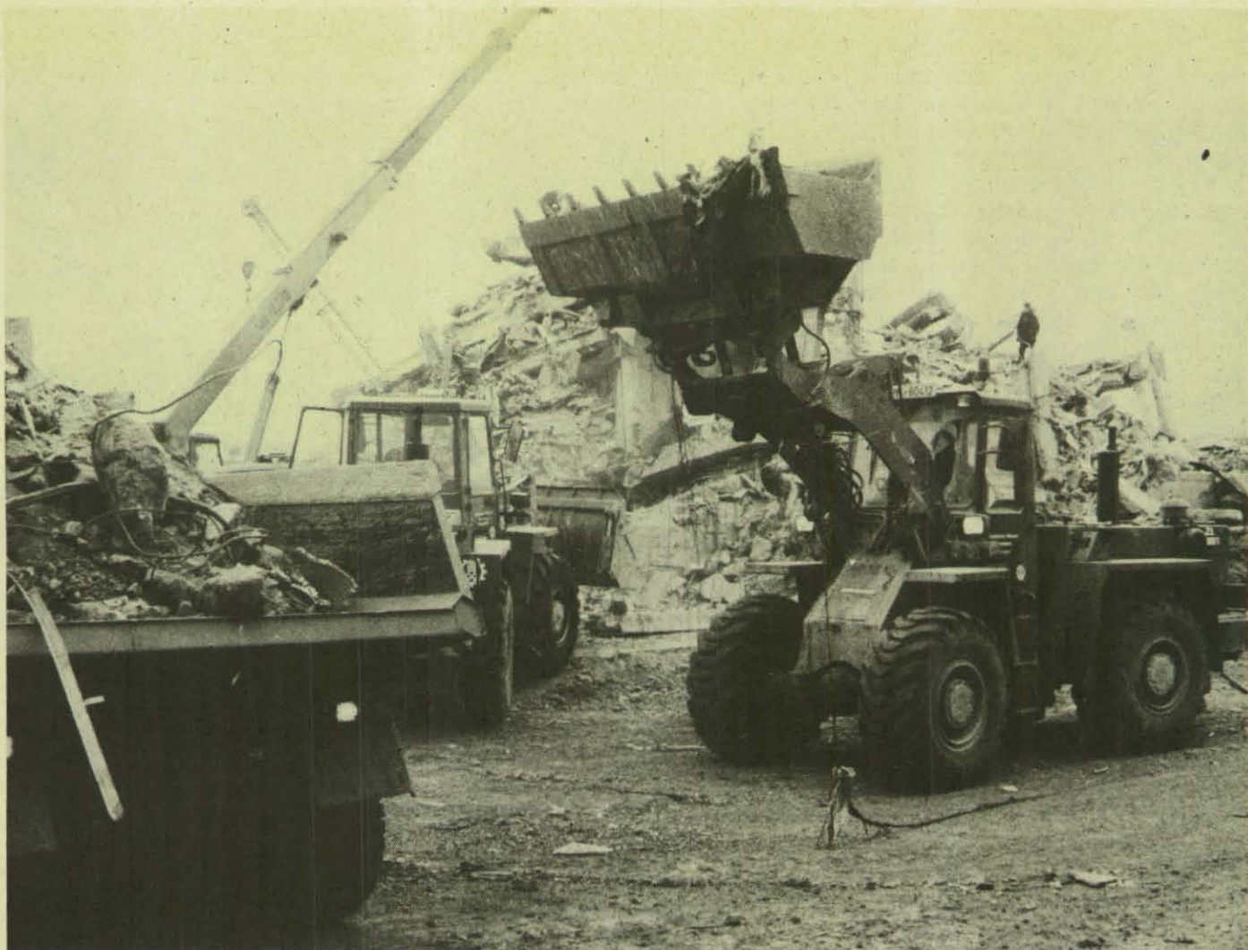
Bergungs- und Räumarbeiten mit schwerem Gerät in Leninakan.
