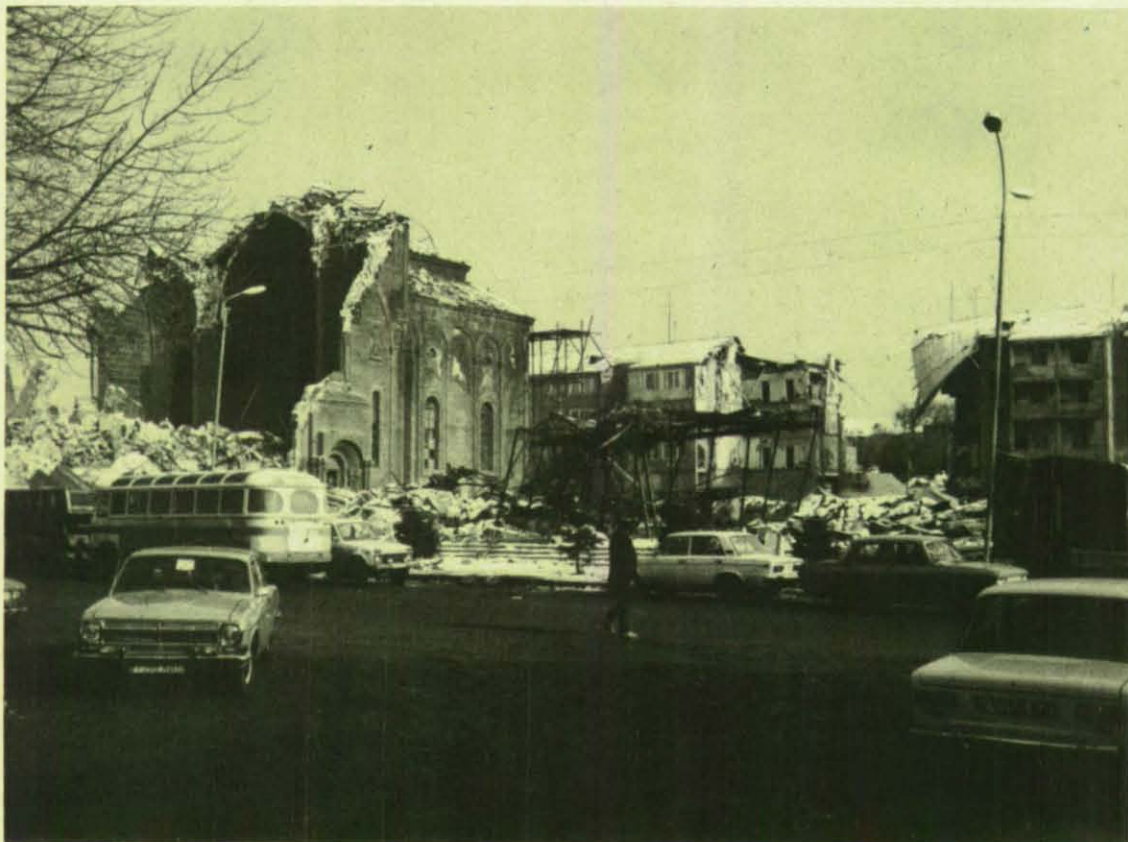
Rund 40 Prozent aller Wohnhäuser sind in Leninakan zerstört.
