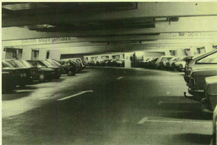
Rund 90 000 neue Schutzplätze in öffentlichen Schutzräumen – hier eine Mehrzweckanlage – wurden 1988 geschaffen. (Foto: Sers)
