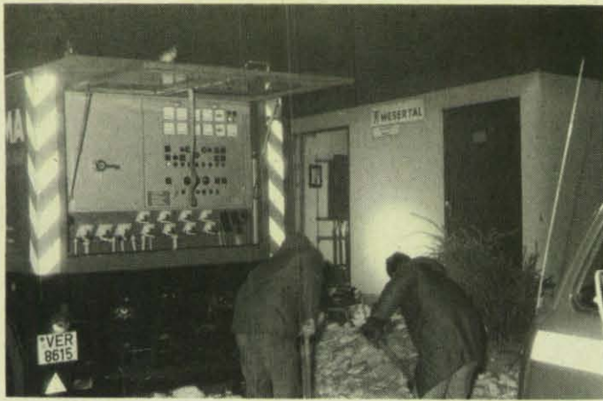
Am späten Abend geht das 175-kVA-Aggregat aus Verden ans Netz.
