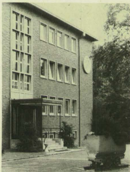
Bergbau auf Schritt und Tritt: Der Eingangsbereich der Hauptstelle in Essen.
