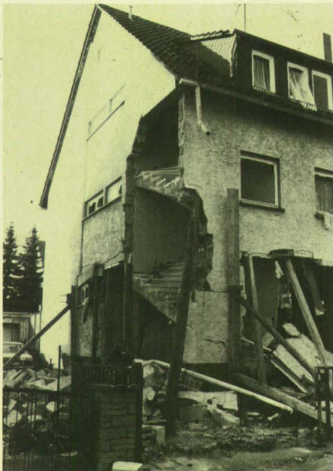
Durch Abstützungen werden Gebäude vor dem Einsturz bewahrt.
