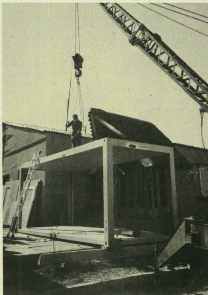
Die ersten Wohn-Container werden aufgestellt.
