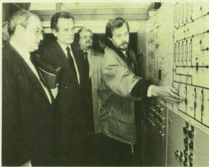
Bei der Übergabe des neuen Schutzraumes weist ein Firmenmitarbeiter in die Technik ein. Von links: Professor Dörr, Innenminister Geil und BVS-Landesstellenleiter Awisus. (Foto: Sämmner)
