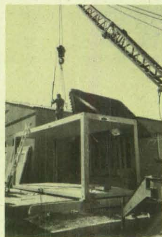
Container-Aufbau durch DRK-Helfer als Ersatz für zerstörte Gebäude.
