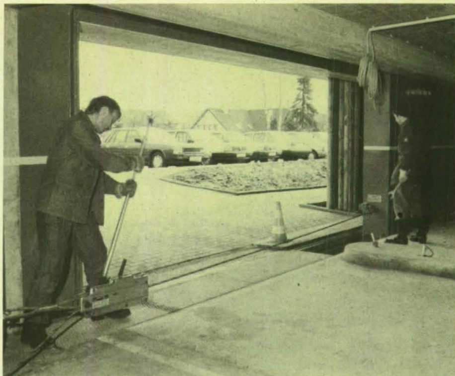
THW-Helfer demonstrieren, wie das schwere Betonschiebetor im Notfall mit Hilfe eines Greifzugs geschlossen wird.
