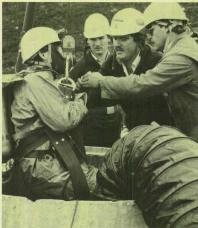
Der mit schwerem Atemschutz ausgerüstete Helfer wird in den Schacht abgelassen.
