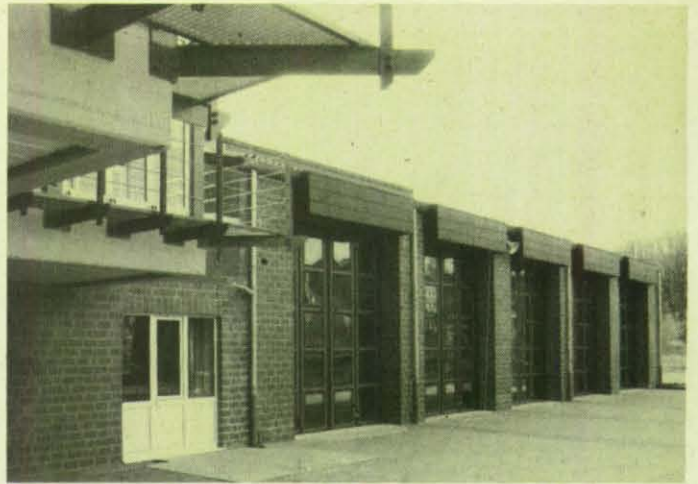
Der Bereich der Rettungswache mit fünf Fahrzeugstellplätzen.
