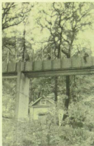
Geschafft: Die Brücke steht im wesentlichen.
