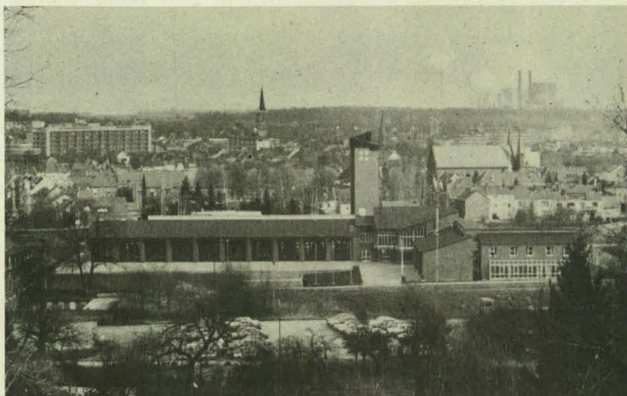
Ein Blick auf die zentral gelegene neue Feuer- und Rettungswache in Eschweiler.
