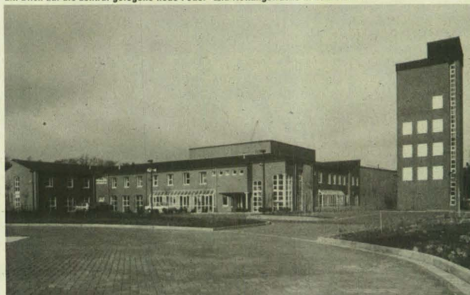
Die Rückseite des Gebäudekomplexes mit dem Schlauchtrocken- und Übungsturm.
