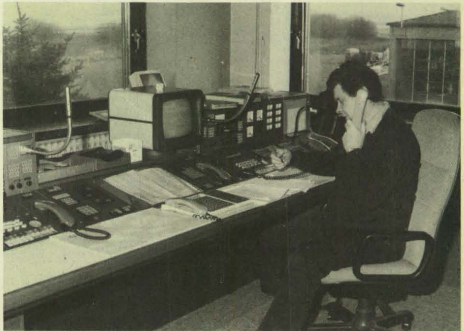
Die Leitstelle der Flughafenfeuerwehr ist mit modernster Nachrichtentechnik ausgestattet.
