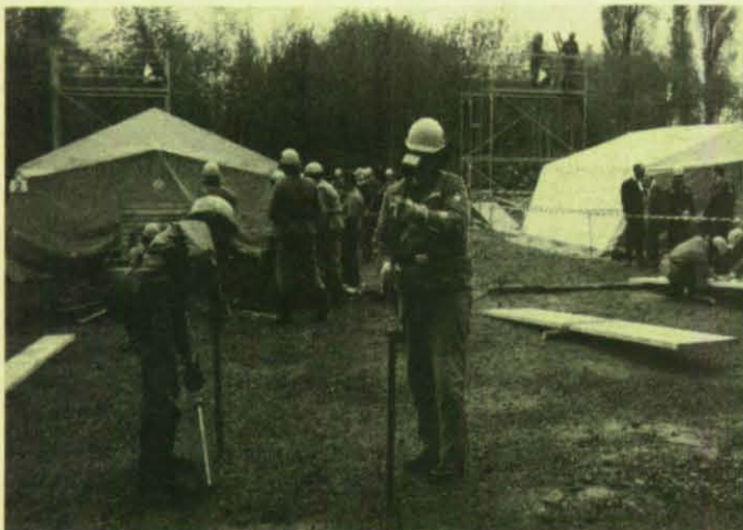
Die Helfer bereiten den Bau eines Trümmersteiges vor.
