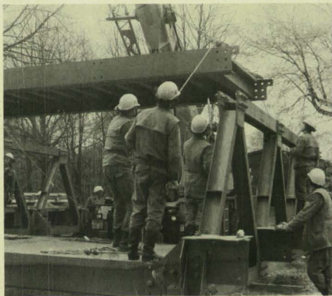
Die Fahrbahnplatten werden eingesetzt.
