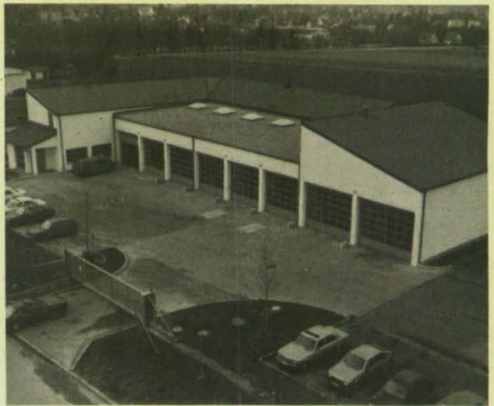
Die Außenansicht der Kats-Zentralwerkstatt.
