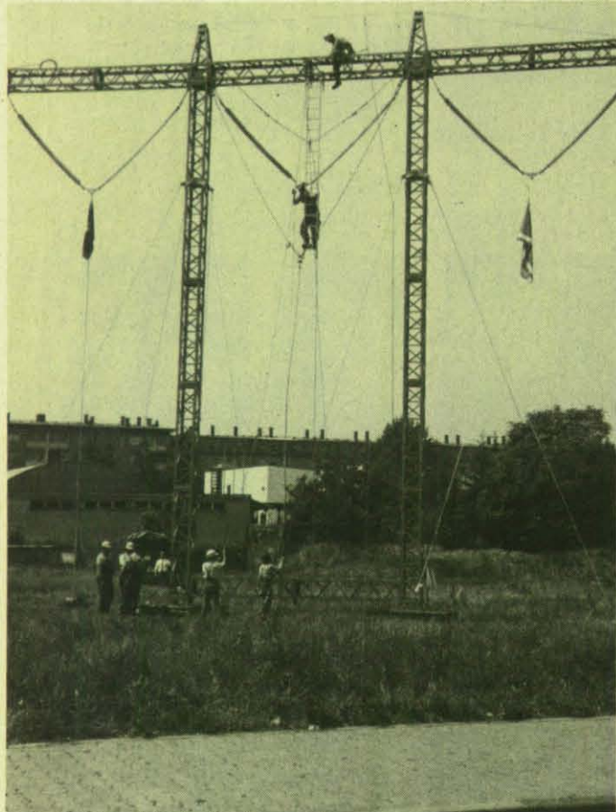
Nach dem Aufbau erfolgt die Montage der Isolatoren am T-Portal.
