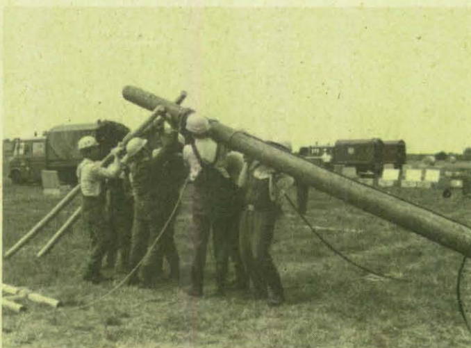
Ein hartes Stück Arbeit: Helfer stellen einen Freileitungsmast auf.
