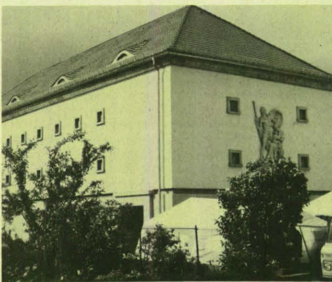
Mit seinen zwei Meter dicken Betonmauern erfüllte der alte Hochbunker aus dem II. Weltkrieg erst die Grundvoraussetzungen für den heutigen Schutzraum-Standard. Nach einer gründlichen Überarbeitung entspricht er nun dem „Grundschutzstandard für kurzzeitigen Aufenthalt“.
