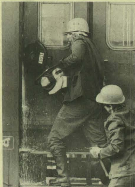
Die Türen des Zuges waren schwer zu knacken: Um einen Zusammenstoß zweier Züge zu simulieren, waren sie teilweise zugeschweißt worden.
