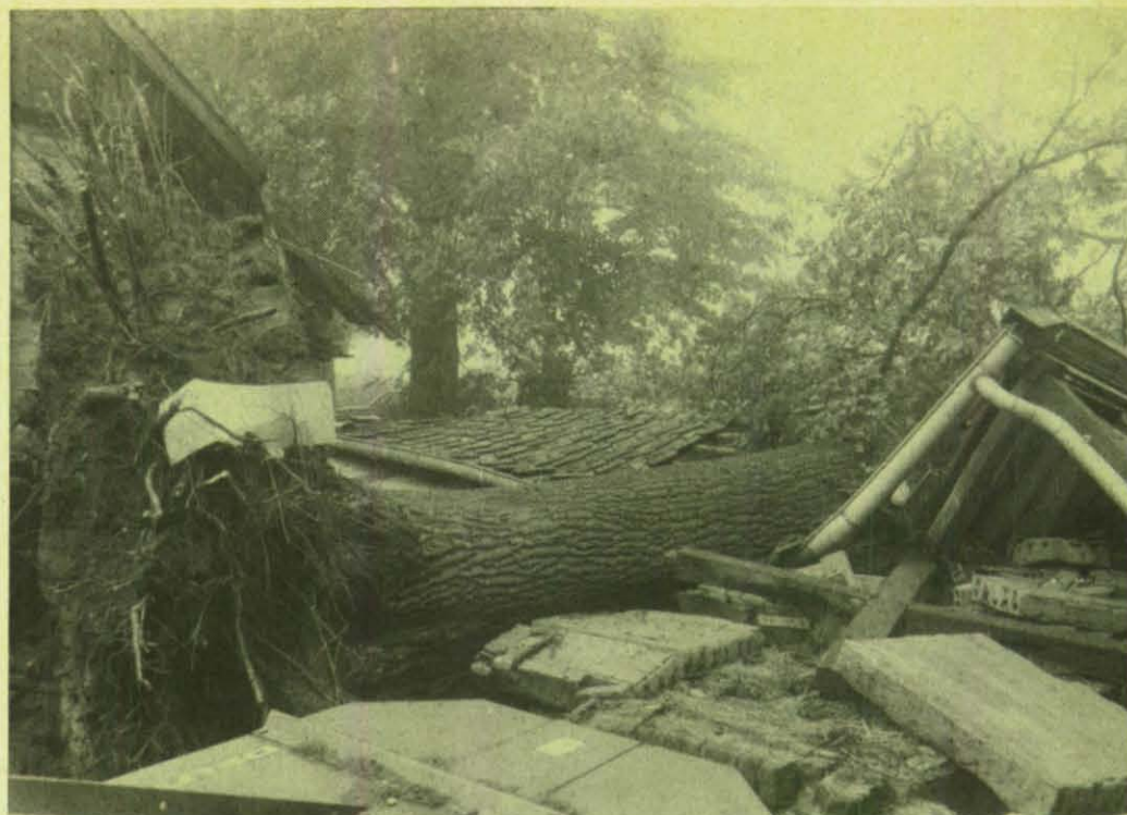
Die Scheune war der tonnenschweren Eiche nicht gewachsen.
