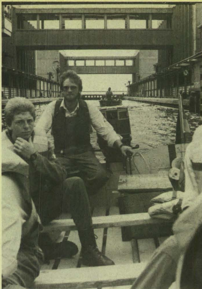
Ein Erlebnis: Die Schleusung im Schiffshebewerk Scharnebeck.
