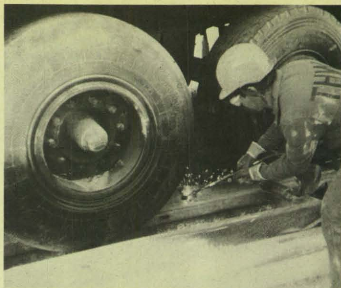
Ein THW-Helfer zerschneidet mit dem Brennschneidergerät die Leitplanke. (Foto: Weiskopf)
