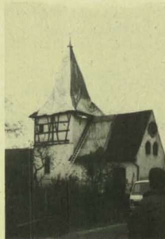
Planen schützen die Kapelle vor Witterungsschäden.
