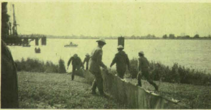
THW-Helfer bringen eine Ölsperre aus.
