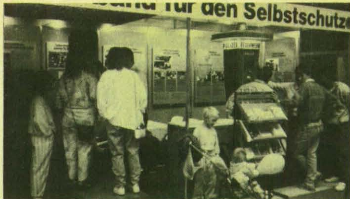
Die aufgebauten Notrufeinrichtungen waren ständig umlagert.
