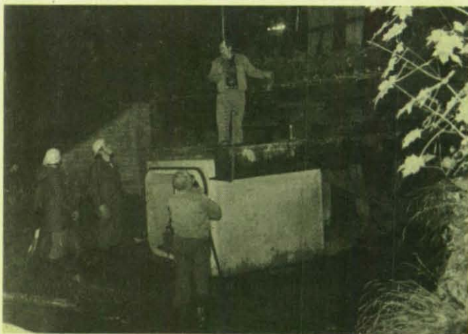
In gemeinsamer Arbeit werden die Stahlträger unter die Brücke geschoben.
