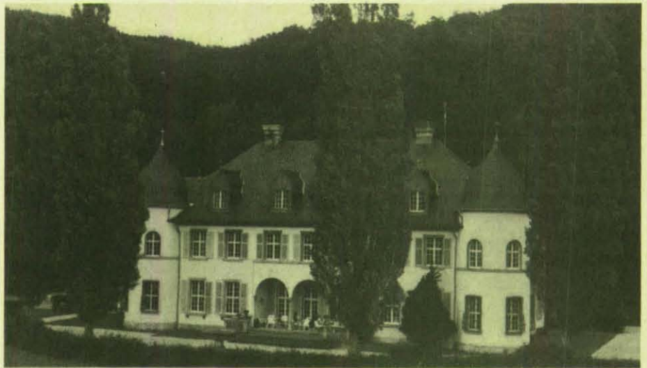
Ein ansprechendes Gebäude: Die Katastrophenschutzschule Rheinland-Pfalz/Saarland.
