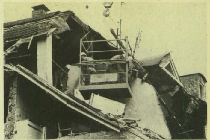
Die Abräumarbeiten werden vom Korb eines Autokrans aus vorgenommen. (Foto: Horn)
