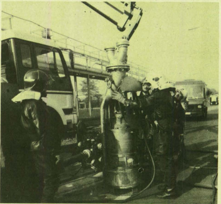
Eine der beiden großen Tauchpumpen wird in Stellung gebracht.
