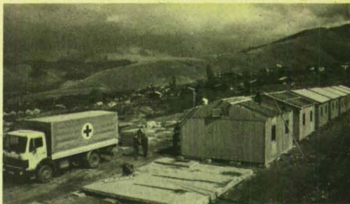
In den 350 vom DRK errichteten Häusern fanden 3 000 Menschen ein neues Zuhause.
