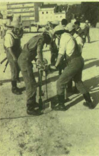
Im Lager Vilshofen bringen THW-Helfer die Verankerungen für das große Versorgungszelt an.
