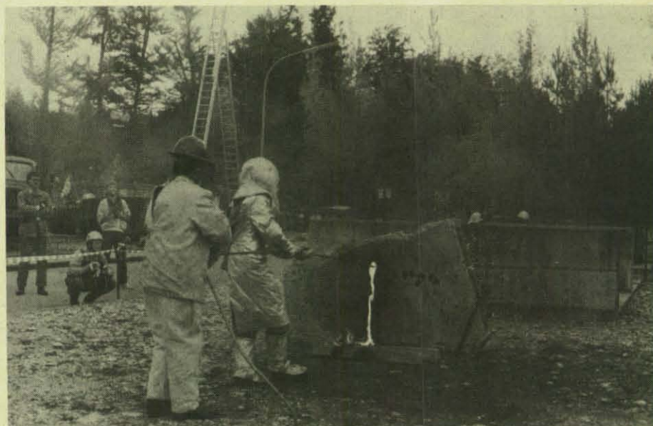
Mit der Sauerstofflanze demonstrieren THW-Helfer das Durchbrechen einer Betonwand.
