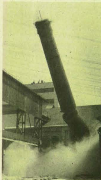
Maßarbeit: Der Kamin fällt genau in die berechnete Richtung.
