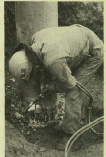
Mit dem Brennschneidgerät ist die Armierung schnell durchtrennt.
