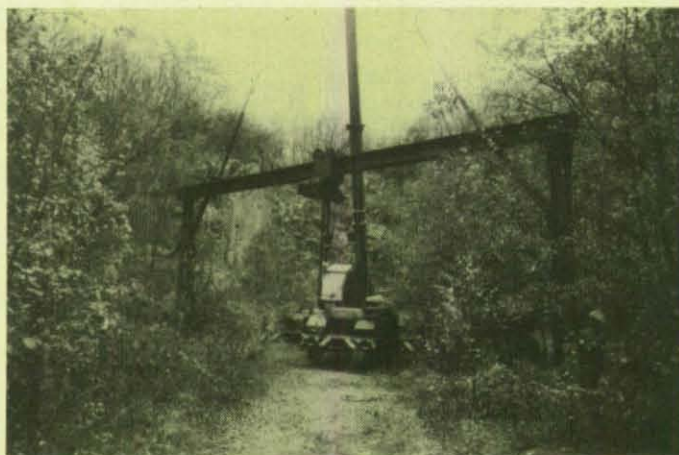
Der Abbau des Portalkrans fordert den THW-Helfern fachliches Können ab.
