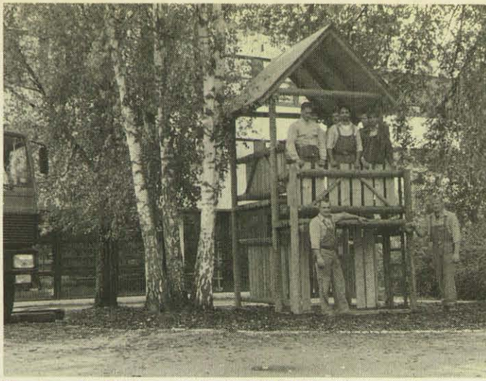
Ein schmuckes Holzhaus schufen die THW-Helfer für die Kinder.
