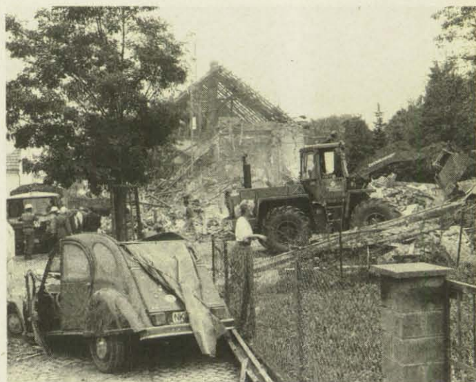
Größere Trümmer des eingestürzten Gebäudes werden mit dem Radlader beseitigt. (Foto: Ruppenthal)
