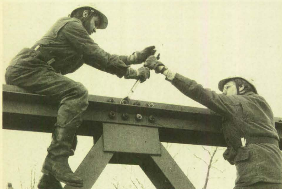
Mit der Hand werden die Einzelteile der Stahlkonstruktion montiert.
