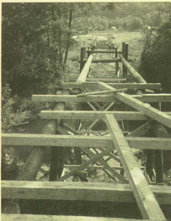
Die Brücke über die Nagold kurz vor der Fertigstellung durch das THW. (Foto: Koch)
