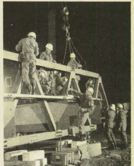
Der erste Einsatztag: Die THW-Helfer montieren den Vorbauschubel der D-Brücke unter Flutlicht.
